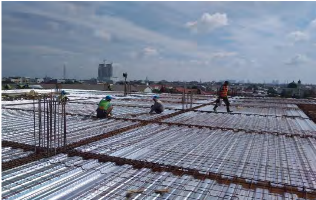
Gambar Pekerjaan Bekisting Plat Lantai
