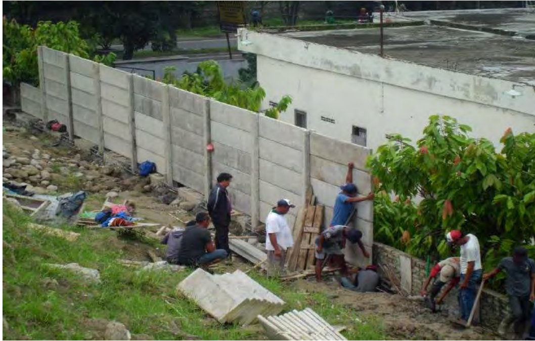
Gambar Pemasangan Pagar Tembok Beton
