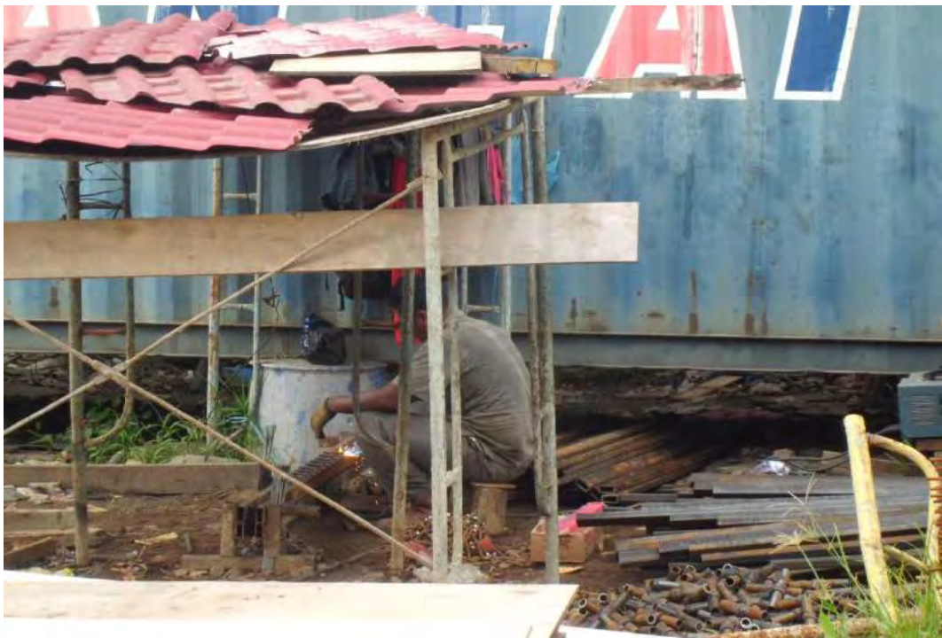
Gambar Pabrikasi Besi di Lapangan
