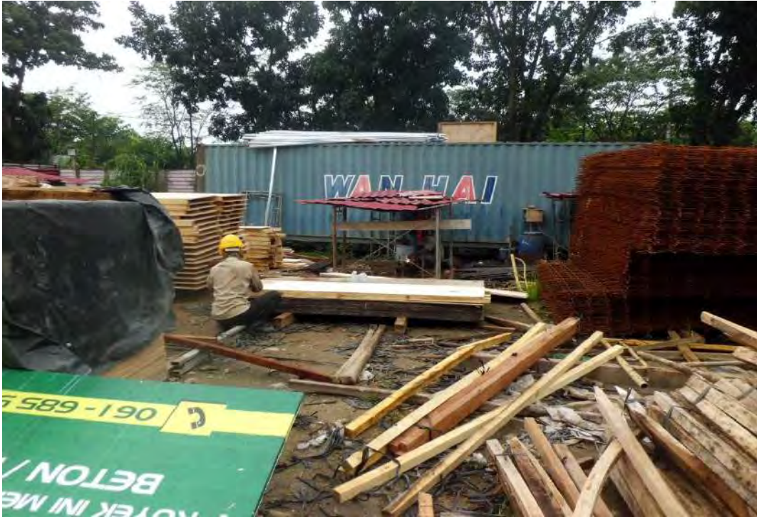
Gambar Pabrikasi Kayu di Lapangan
