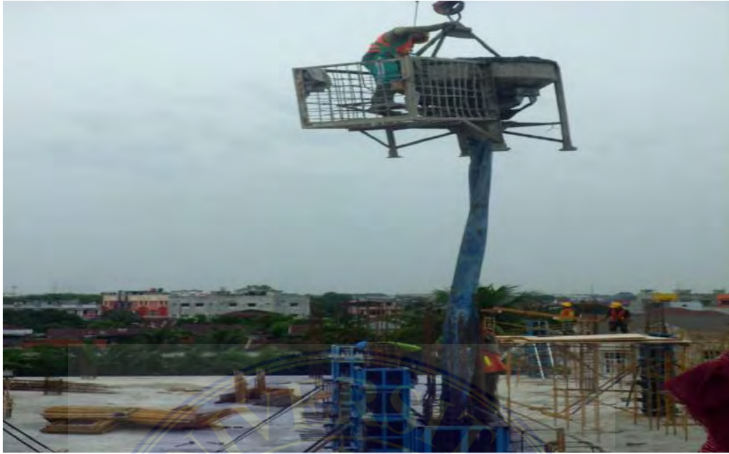
Gambar Pengecoran Kolom
