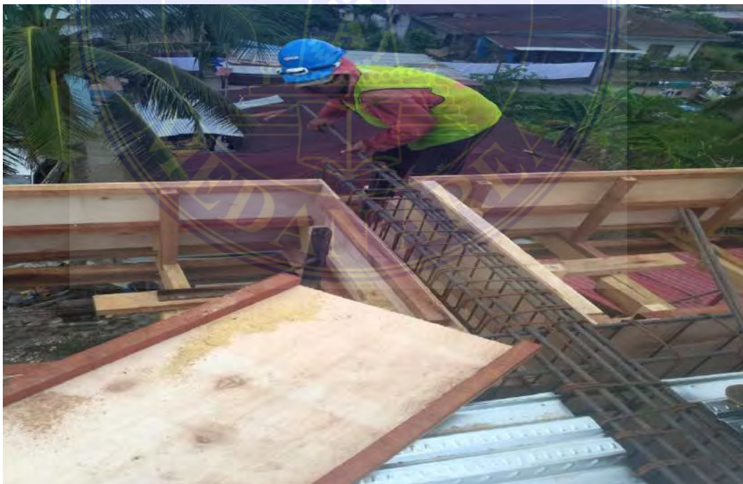
Gambar Pekerjaan Balok
