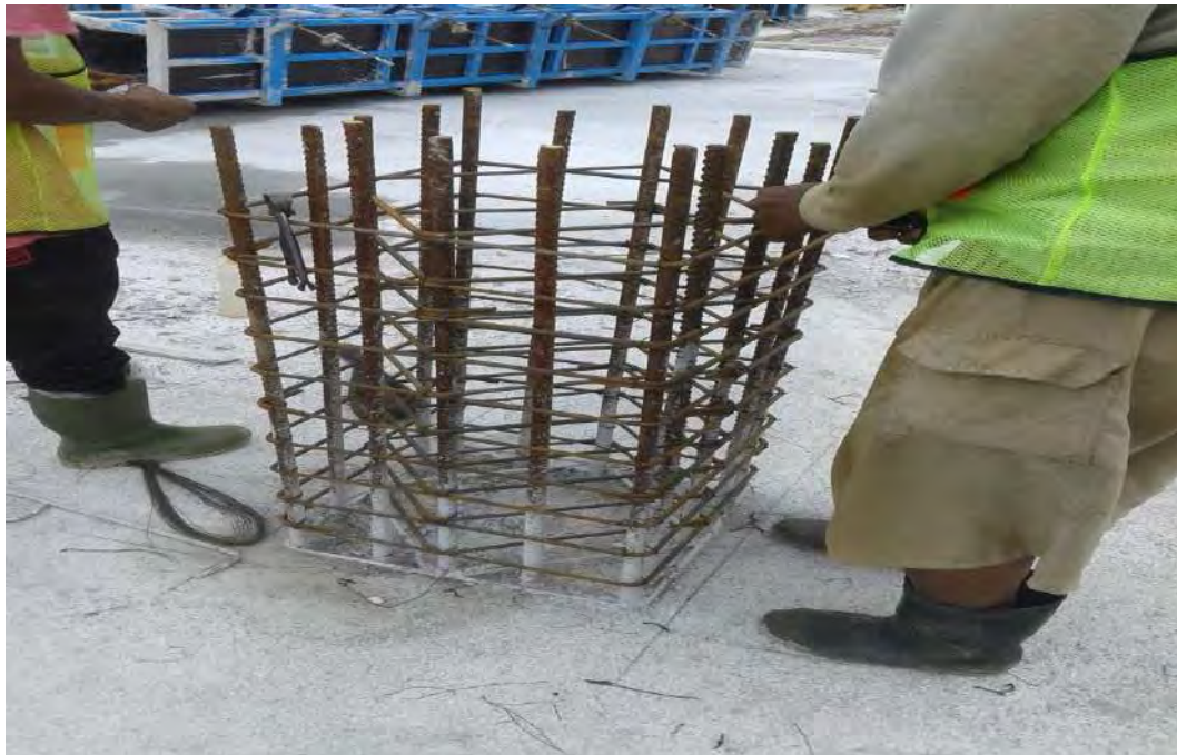
Gambar Pekerjaan Kolom
