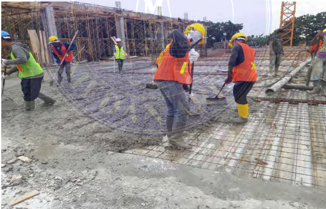
Gambar Pengecoran Plat Lantai dan Kolom
