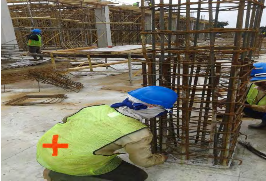
Gambar Pekerjaan Kolom
