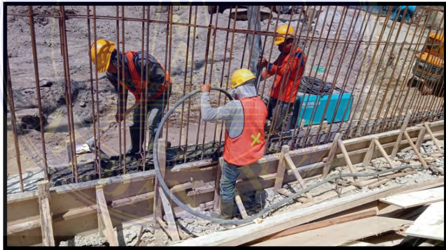
Gambar 4.2 Vibrator Sumber : Dokumentasi
