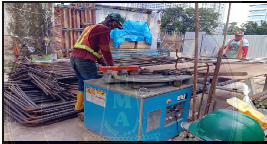
Gambar 3.5 Bar Bender Sumber : Dokumentasi
