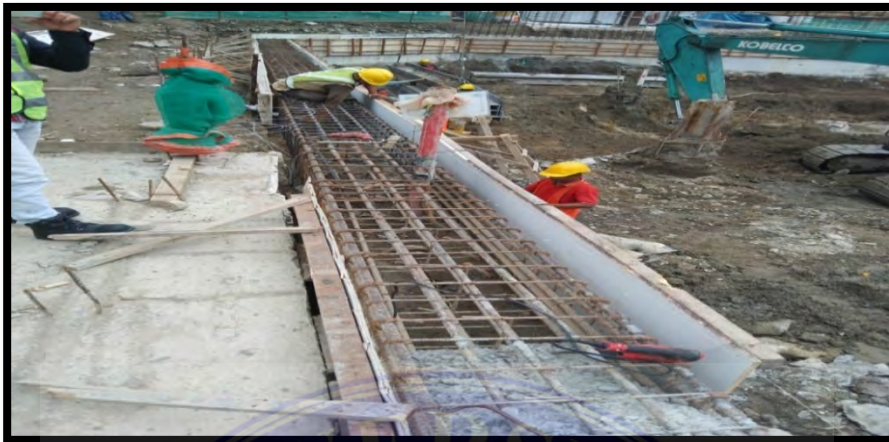
Gambar 3.2 Pemasangan bekisting Sumber : Dokumentasi
