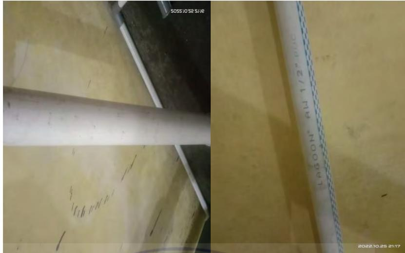
Gambar 3.6. Pipa input 2 inch dan output 1/2 inch
