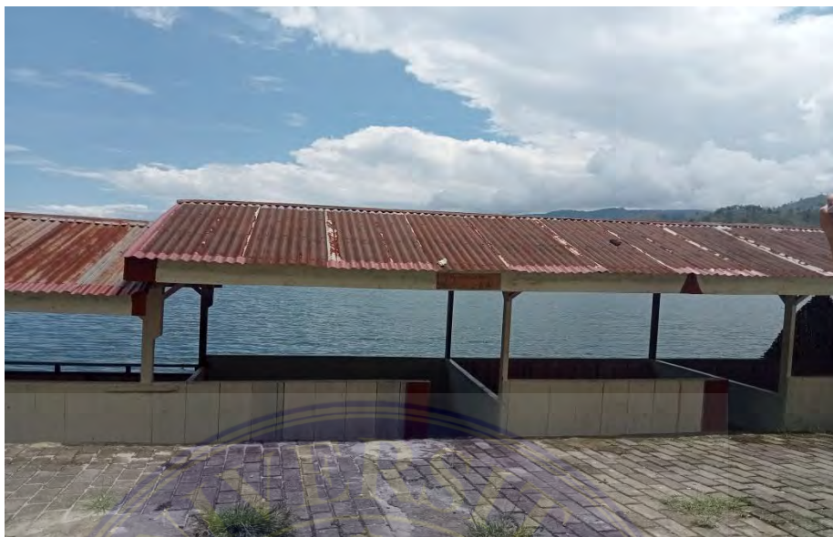
Gambar 5. 13 Pondok/Kios Kuliner (Sumber: Dokumen Pribadi 2023)
