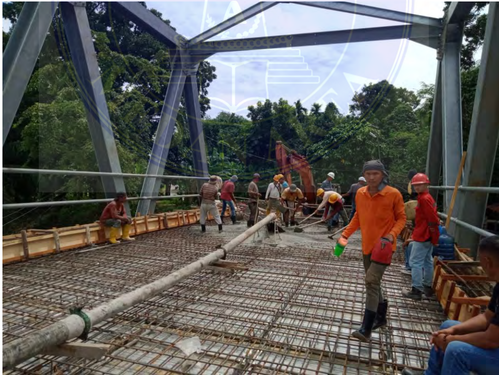
Lampiran 8. Proses pengecoran lantai jembatan
