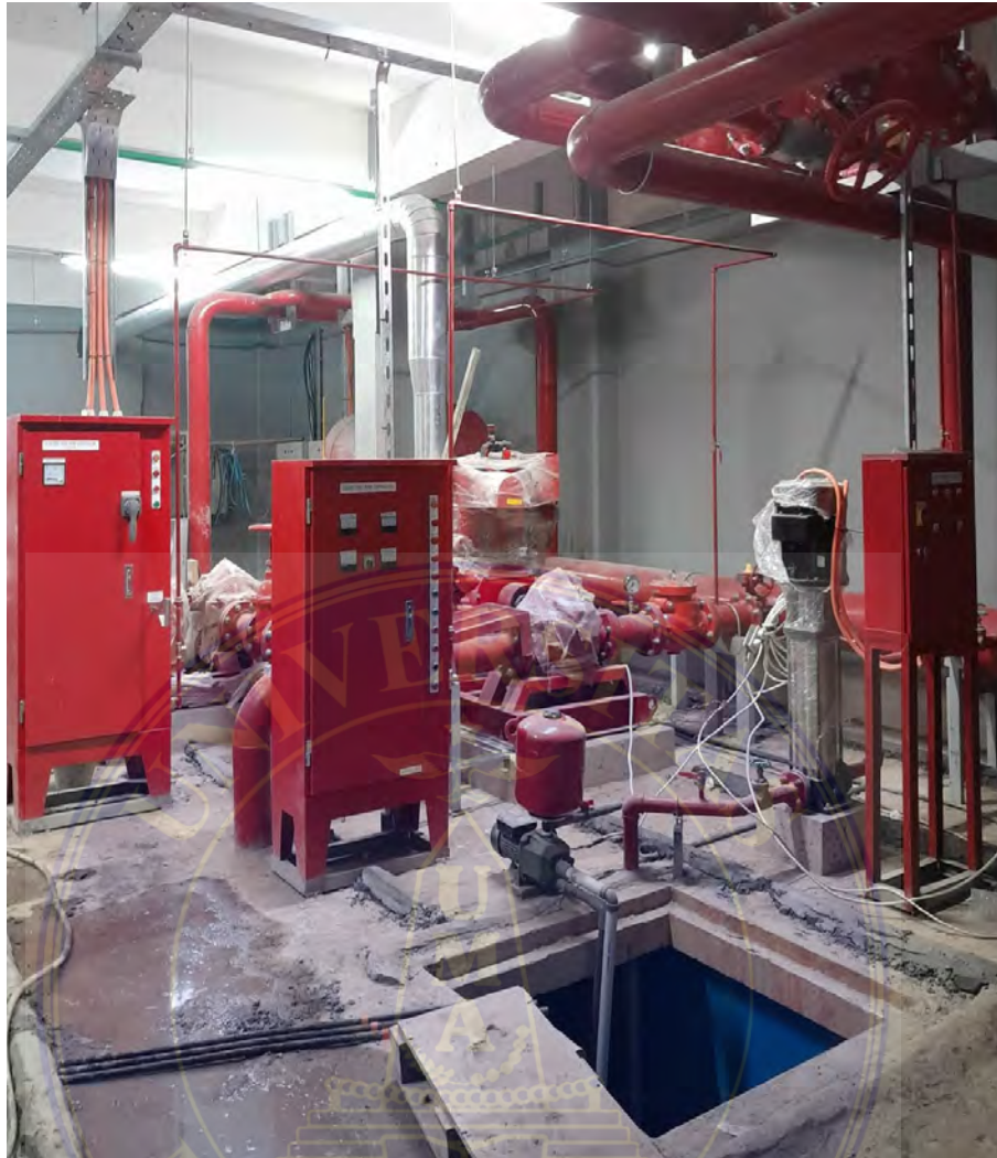
Lampiran 9. Pompa Air Hidran dan Seluruh Peralatan Bantu Air Hidran RS. Regina Maris, 2023.
