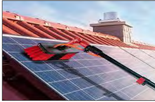
Gambar 2.1 Sapu Manual dengan Air dan Sikat Extentool
