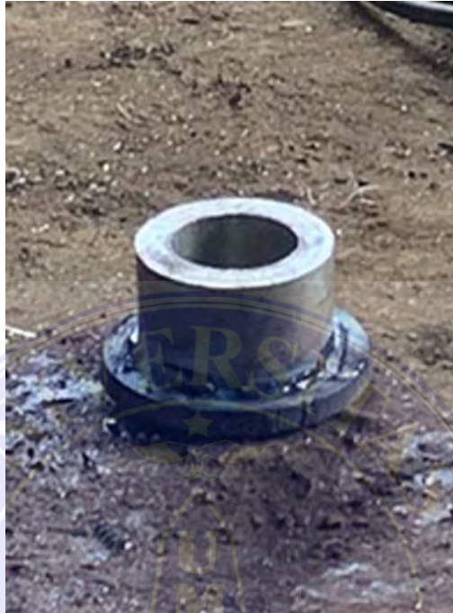
Hasil Pengelasan Heater
