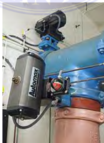
Gambar 2.20 kontrol valve untuk aliran fluida dalam pipa
