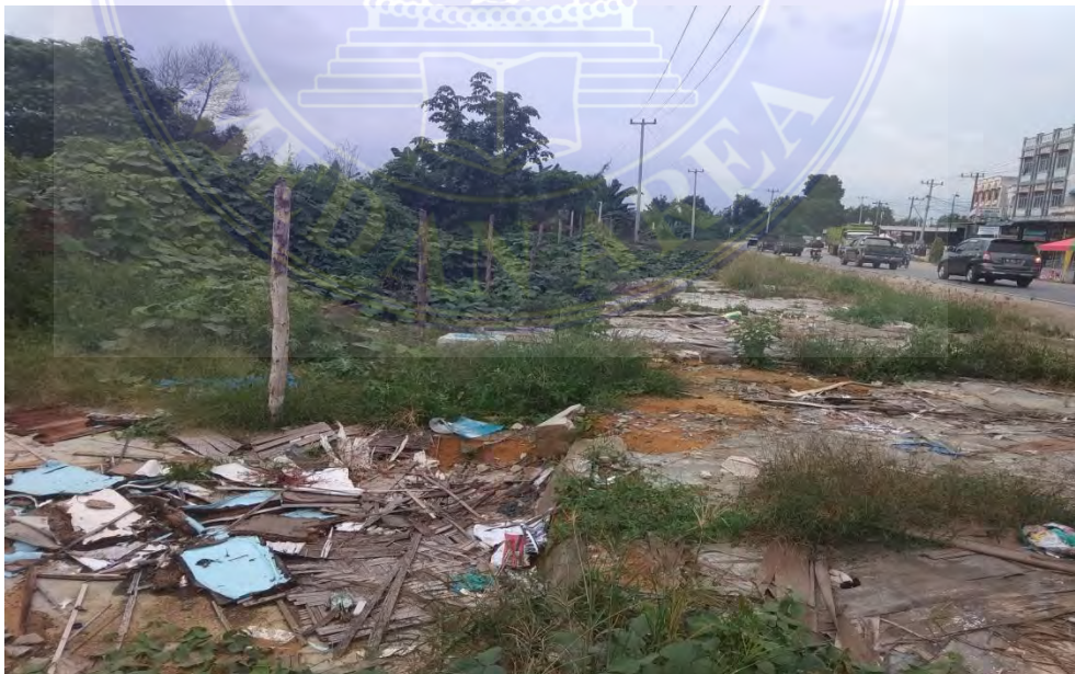
Gambar 6: Salah Satu gambar bekas bangunan yang ditertibkan
