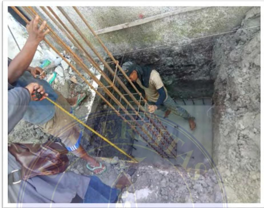
Gambar 1 : Pemasangan Tulangan Pile Cap
