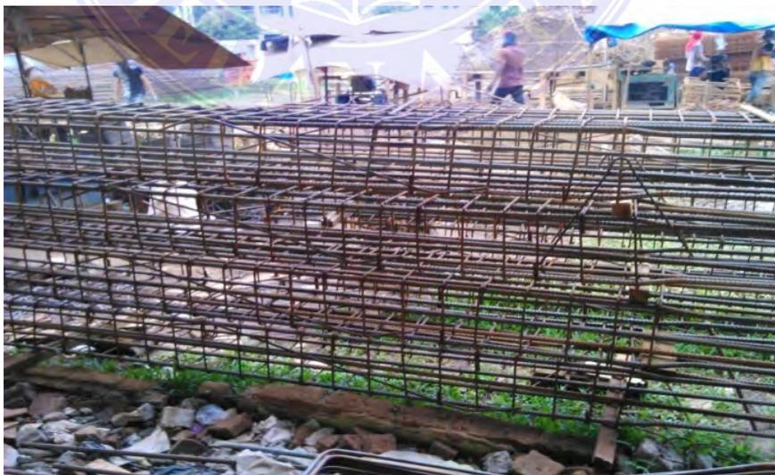
Gambar 3.25. Pekerjaan pemotongan dan pembengkokan tulangan
