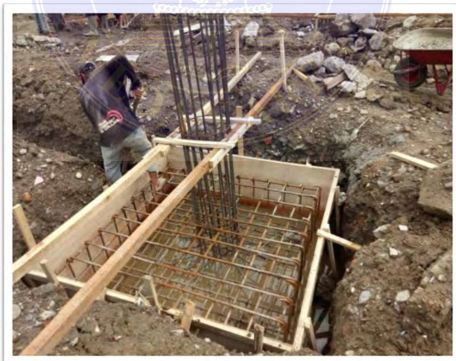
Gambar 2 : Tulangan dan bekisting Pile Cap
