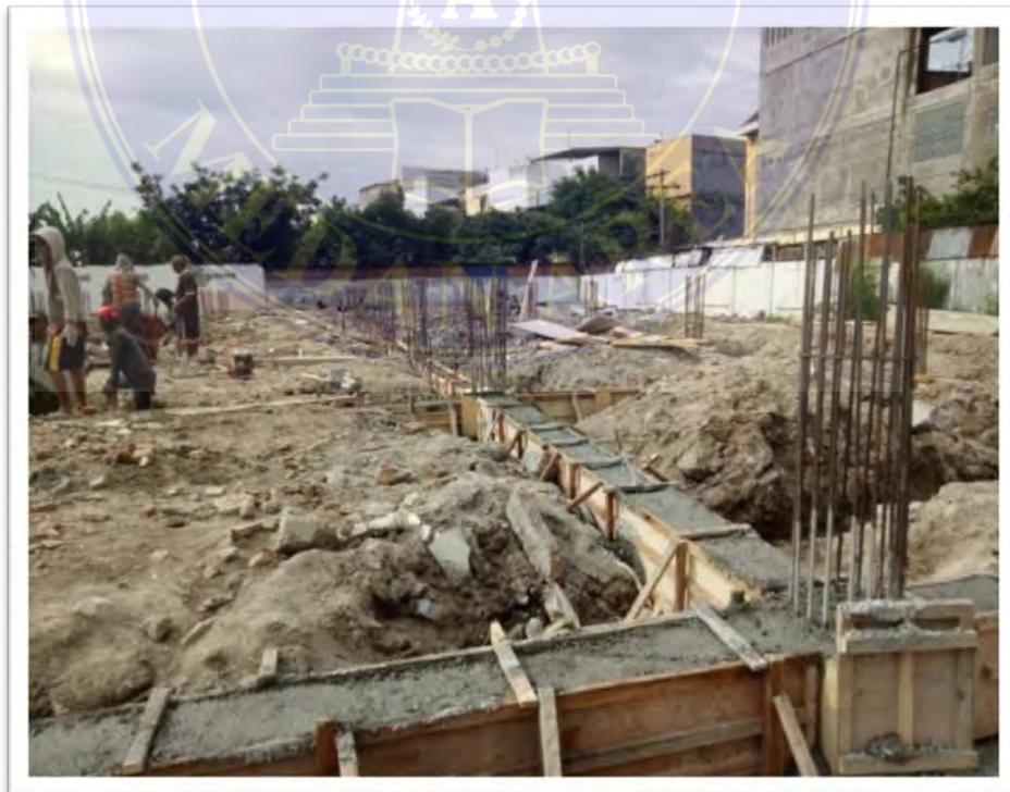
Gambar 6: Pengecoran sloof
