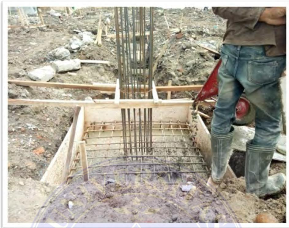
Gambar 3: Pengecoran Pile Cap
