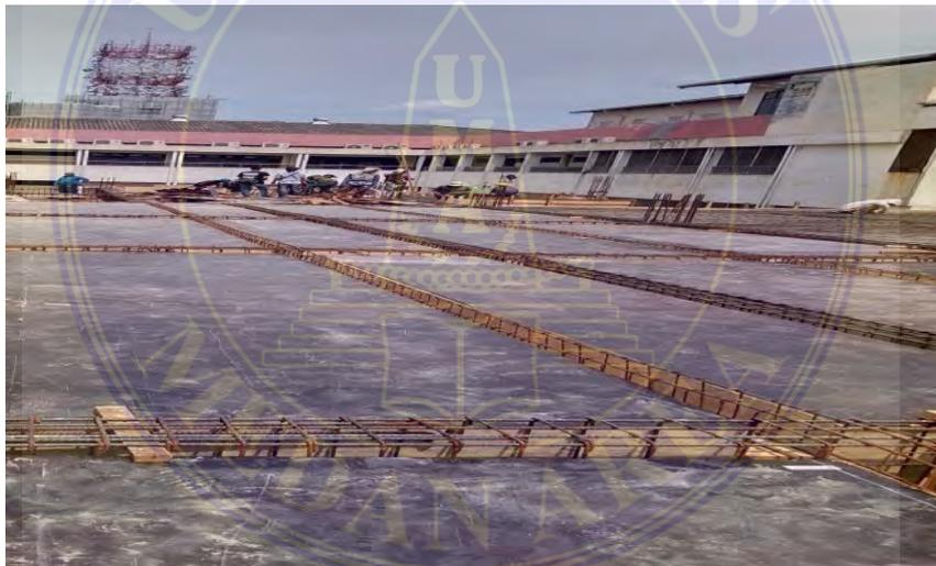
Gambar 3.19 Pemasangan Bekisting Balok dan Plat Lantai
