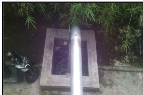
Gambar 6. Bak effluent (sebagai titik koordinat pengambilan sampel air)
