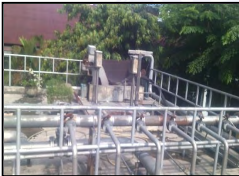
Gambar 3. Lift station, scren dan bak buffer (bak penampung sementara, pemisah dan bak buffer)
