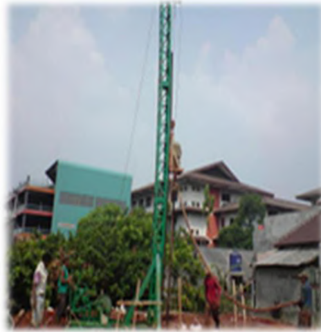
Gambar 2.3 Pembuatan bore pile mini crane
