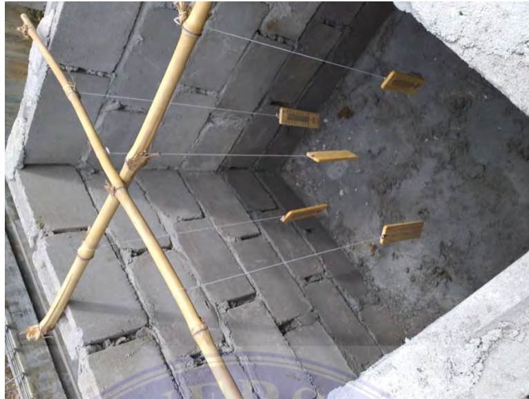
Gambar 15. Proses Pemasangan Alat Ukur Suhu Ruang ( Thermometer Ruang).
