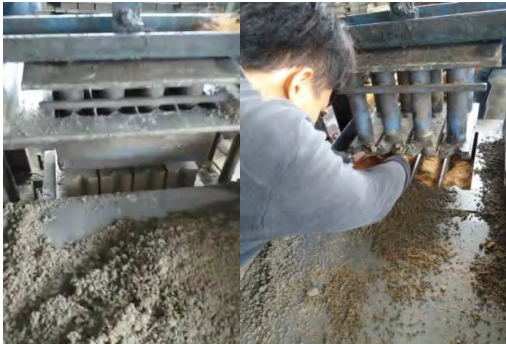
Gambar 2. proses pembuatan batako sabut kelapa.
