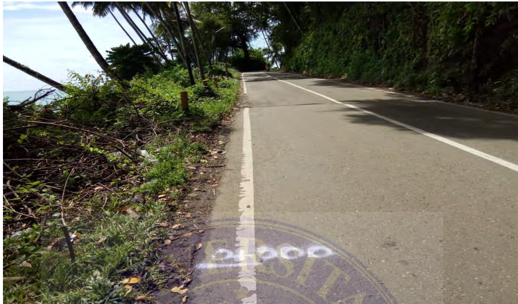
Gambar 3. STA 0+000 Pada Tikungan Laowomaru
