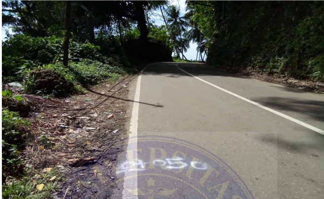
Gambar 5. STA 0+050 Pada Tikungan Laowomaru
