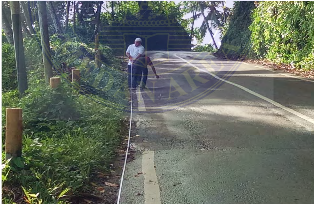
Gambar 8. Pengukuran Jalan Menggunakan Meteran
