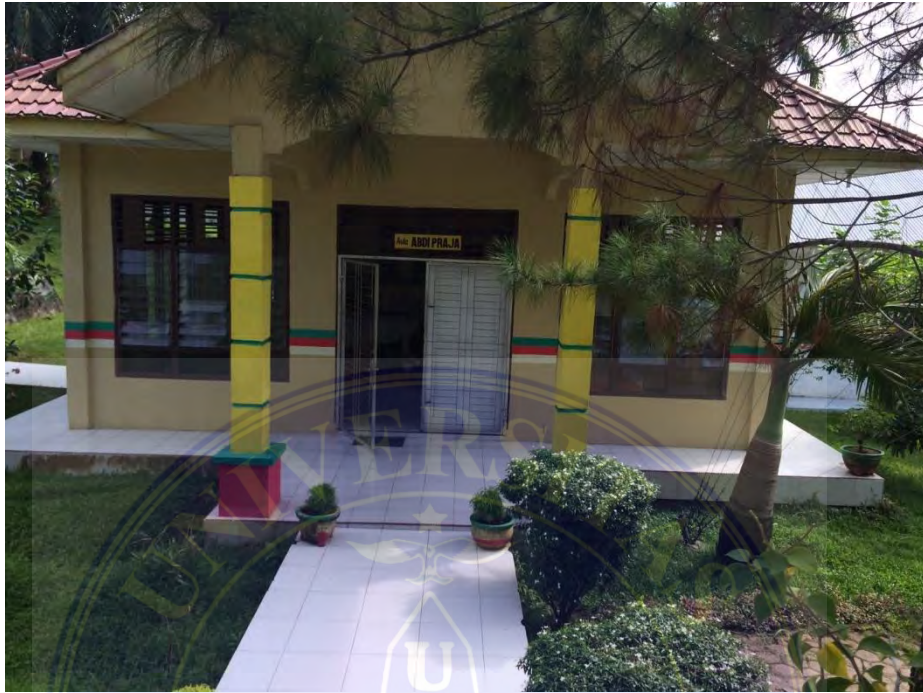
Dokumentasi 5: Kantor Layanan Bagian Administrasi
