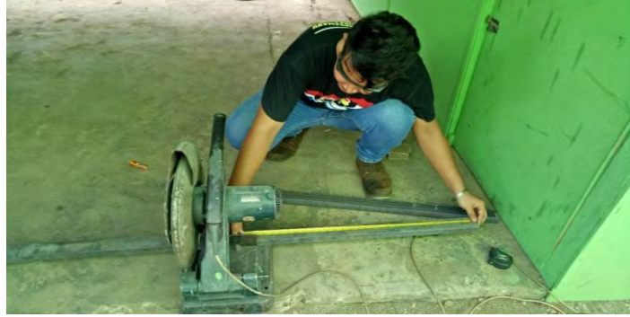
Gambar 3.22 Besi UNP yang telah dipotong
