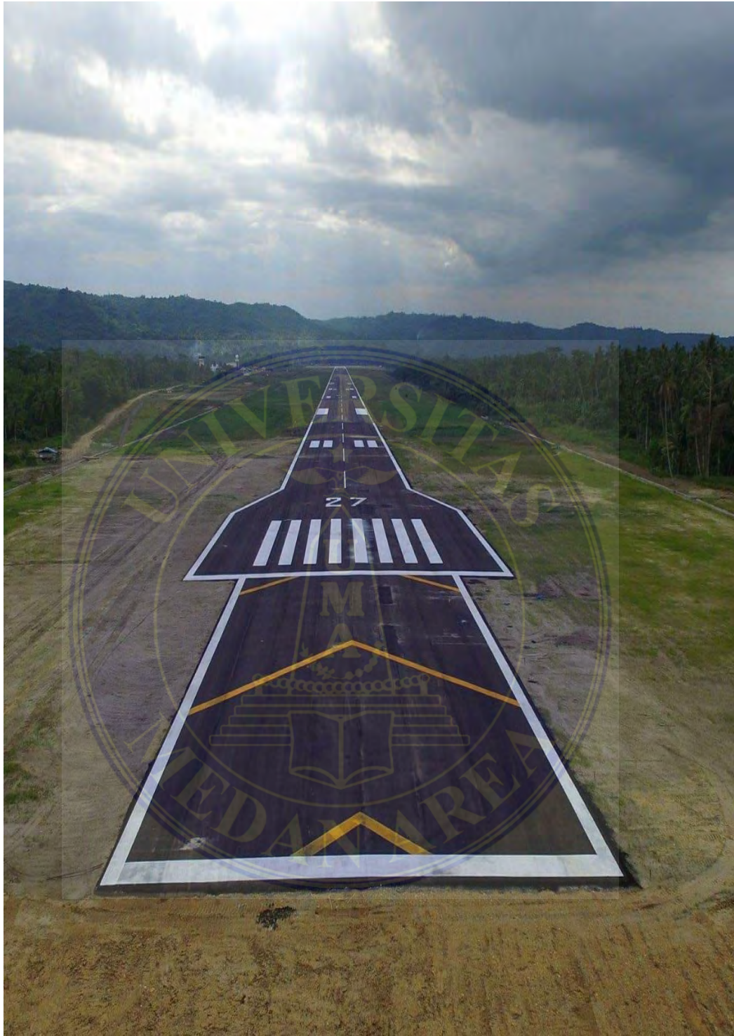
Gambar 3.2 Landasan Pacu Bandar Udara Binaka-Gunungsitoli, Nias (Sumber : Bandar Udara Binaka-Gunungsitoli, Nias Tahun 2019)
