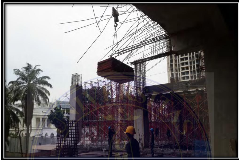
Gambar 7. Pengangkutan material bekisting menggunakan Tower Crane
