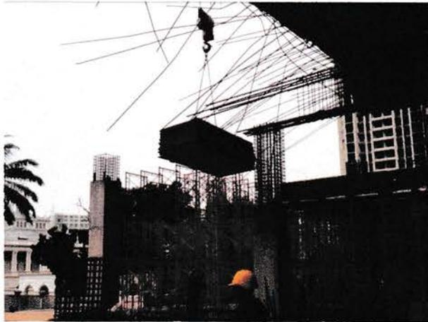
Pengangkutan material bekisting menggunakan Tower Crane
