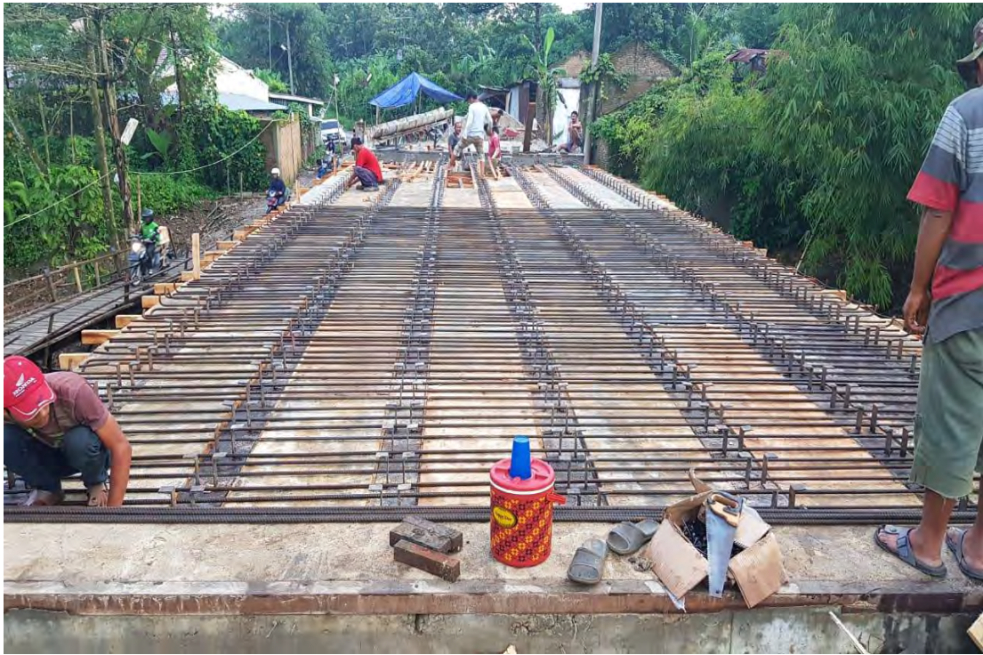
Gambar Pemasangan Tulangan Slab Lantai
