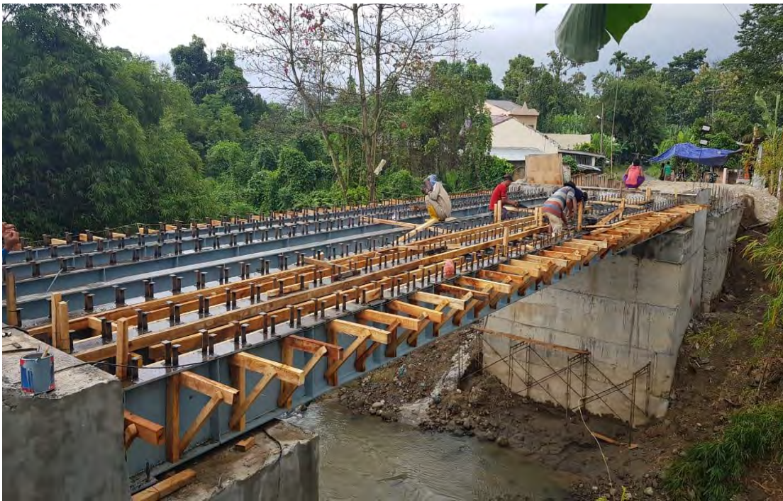
Gambar Pemasangan Mal Lantai
