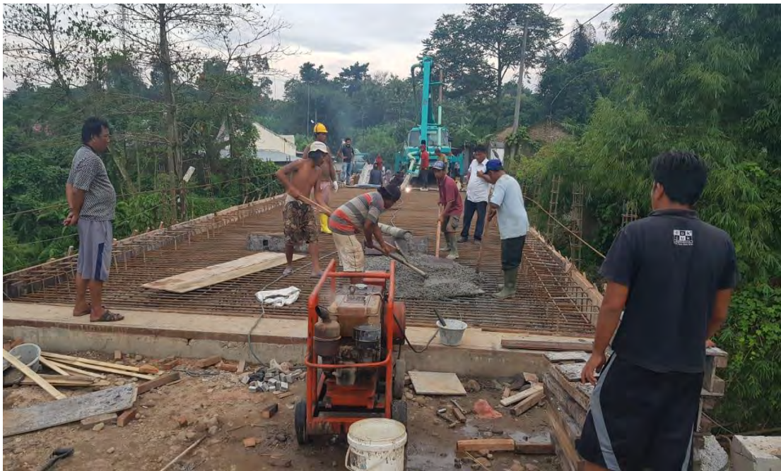
Gambar Pengcoran Slab Lantai
