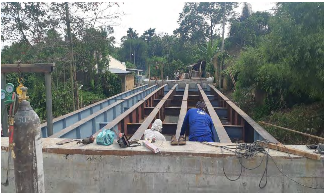
Gambar Pemasangan Diafragma dan Pengelasan dengan Las Listrik
