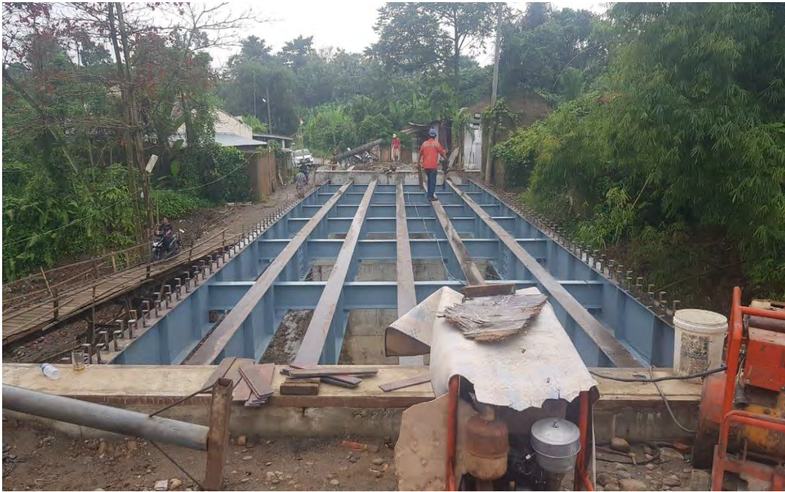
Gambar Pemasangan Shear Connector
