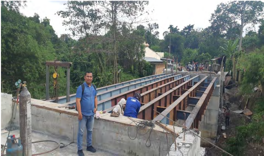
Gambar Pemasangan Stifner dan Pengelasan dengan Las Listrik
