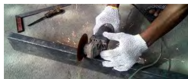
Gambar 3. 34. Pemotongan Besi Hollow untuk penyangga
