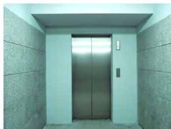
Gambar 5.17. Elevator sebagai transportasi Vertikal
