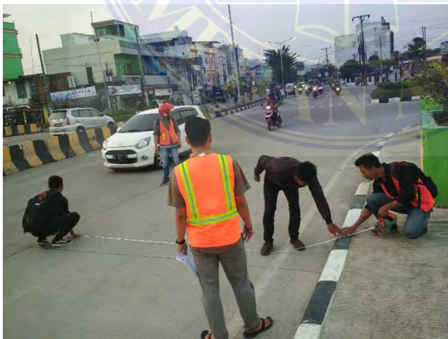
Gambar pengukuran geometrik jalan Katamso
