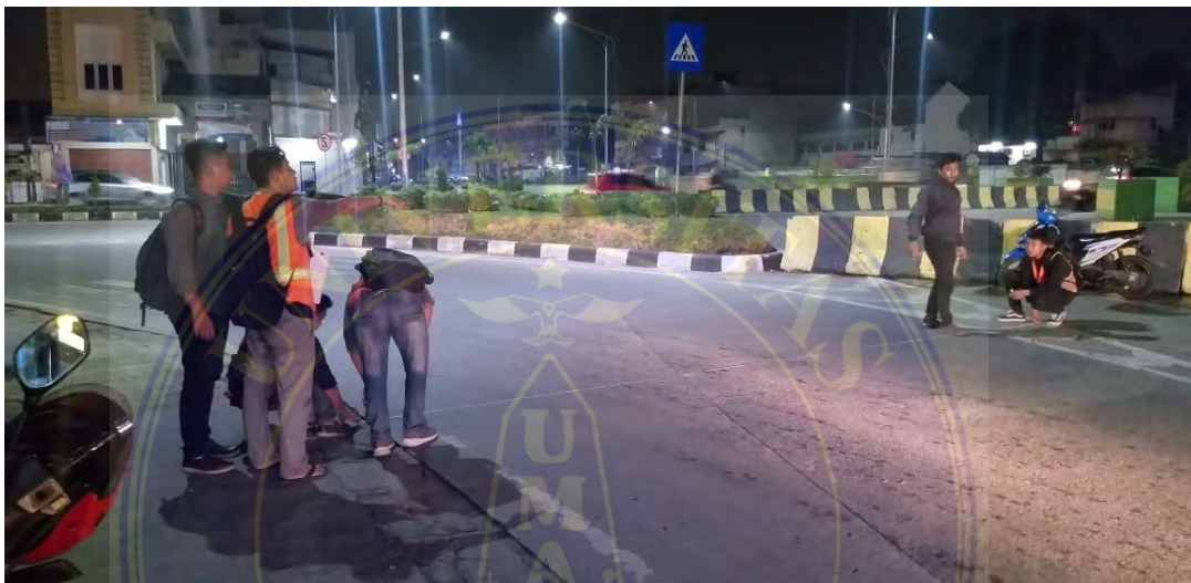
Gambar pengukuran geometrik jalan A.H Nasution
