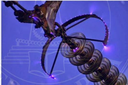
**Gambar 2.5 Efek Korona pada saluran transmisi**
