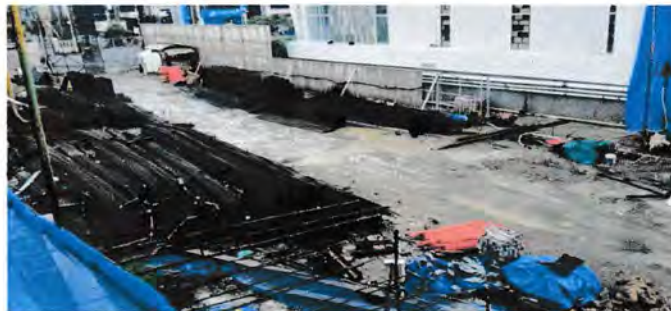
Gambar 4.7 Pembesian Lanta Sumber : Data lapangan ,2016
