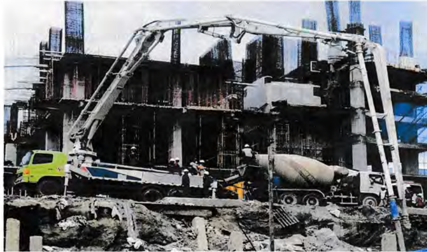
Gambar 4.10. Concret Pump Sumber : Data lapangan ,2016
