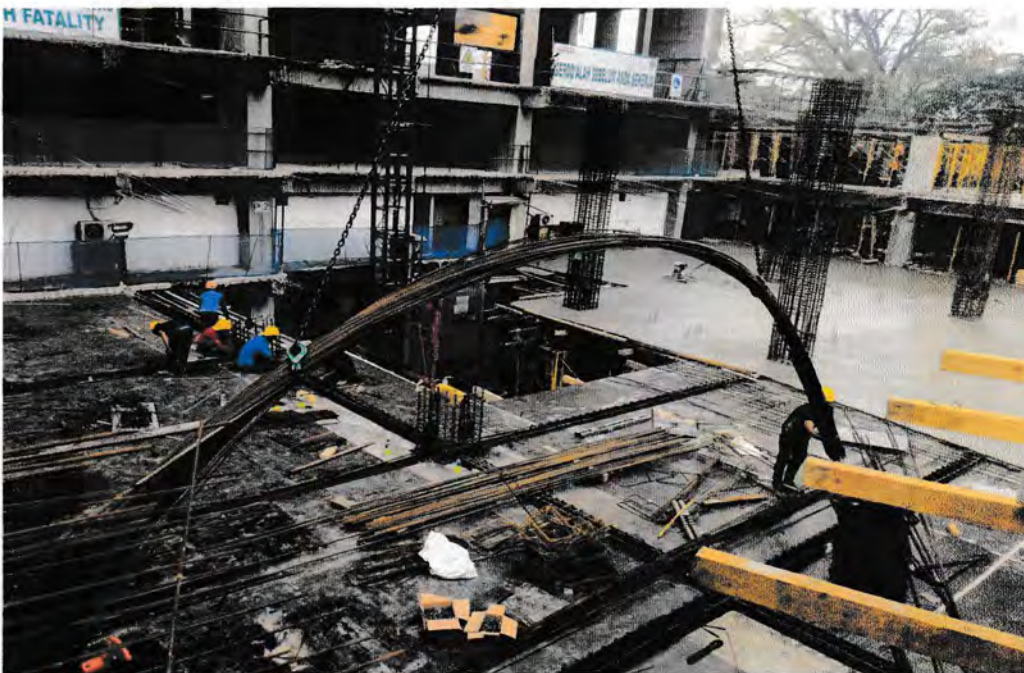
Gambar 5.2 Pembesian Lantai, Sumber : Data lapangan ,2016
