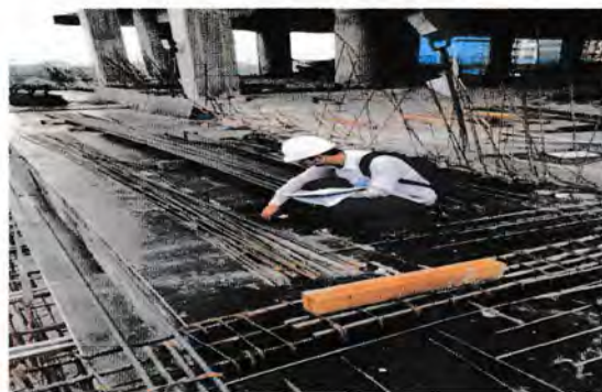
Gambar 4.15 Bekisting Lantai ,Sumber : Data lapangan ,2016
