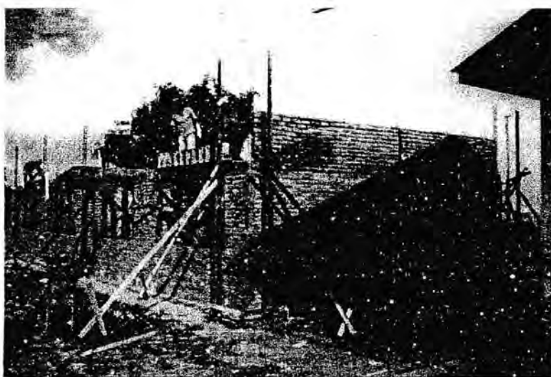
Gambar 4.2. Pelaksanaan Proyek Pembangunan Ruang Kelas Baru 2 Lokal Desa Manompas
