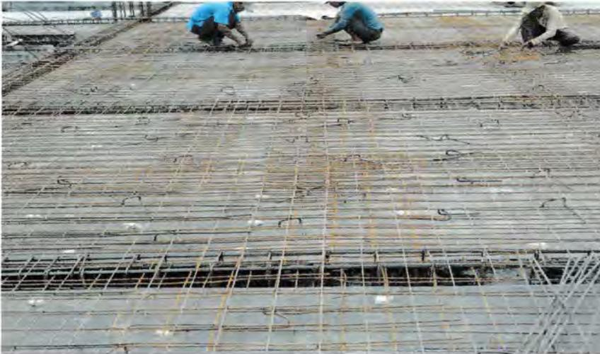
Gambar : Pekerjaan pembesiaan pada lantai
