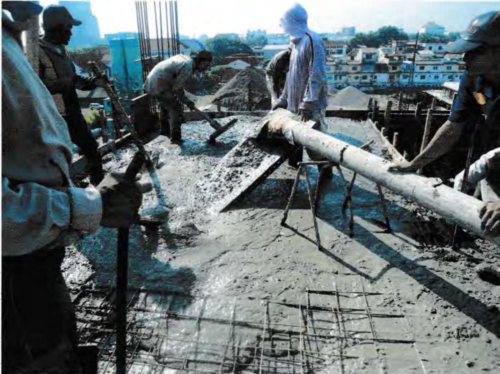
Gambar : Pengecoran pada lantai
