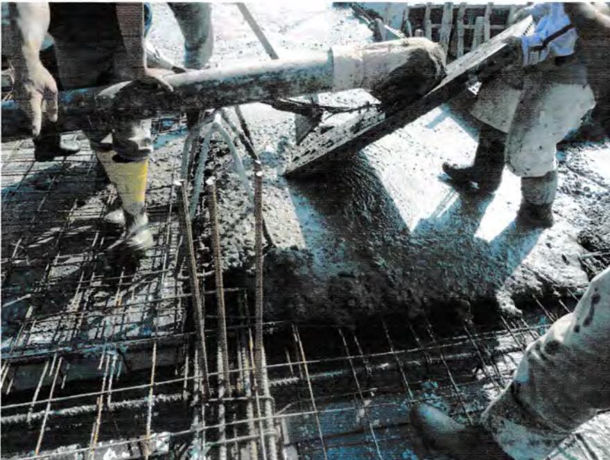
Gambar : Pengecoran Plat Lantai dengan bantuan Concrete Pump
