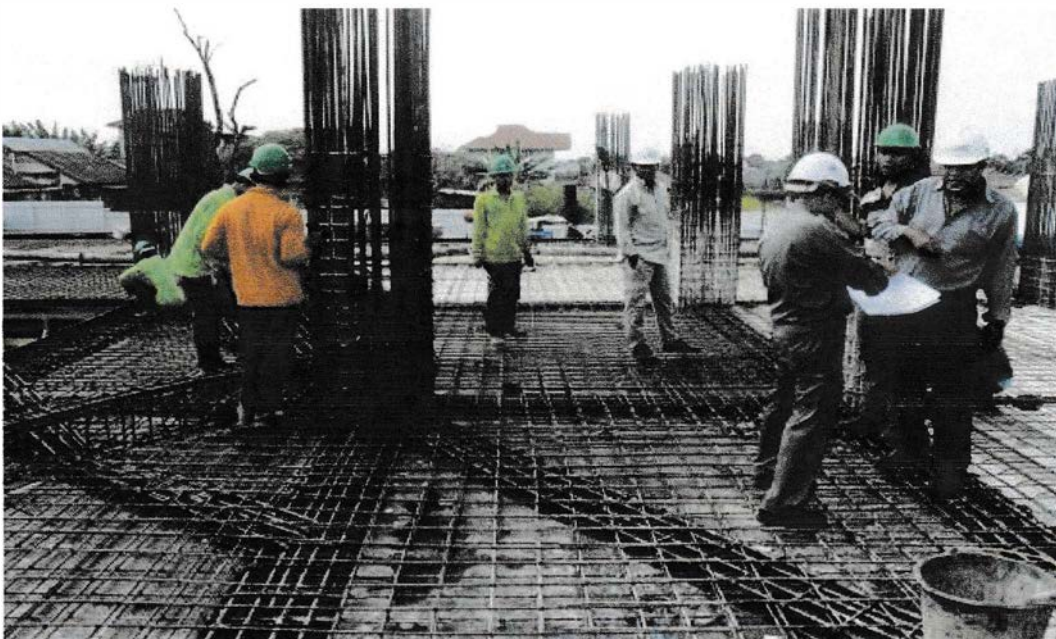
Gambar 8 : Pembesian Lantai 2 Gedung Kedokteran UISU
