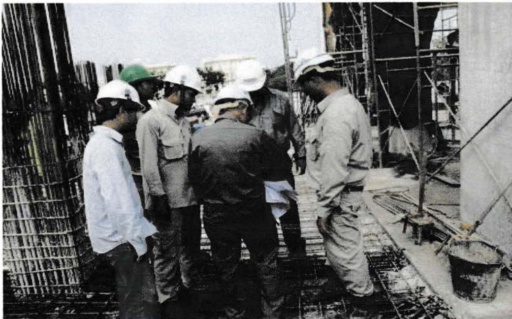
Gambar 10 : Ceklist Pekerjaan Sebelum Pengecoran
