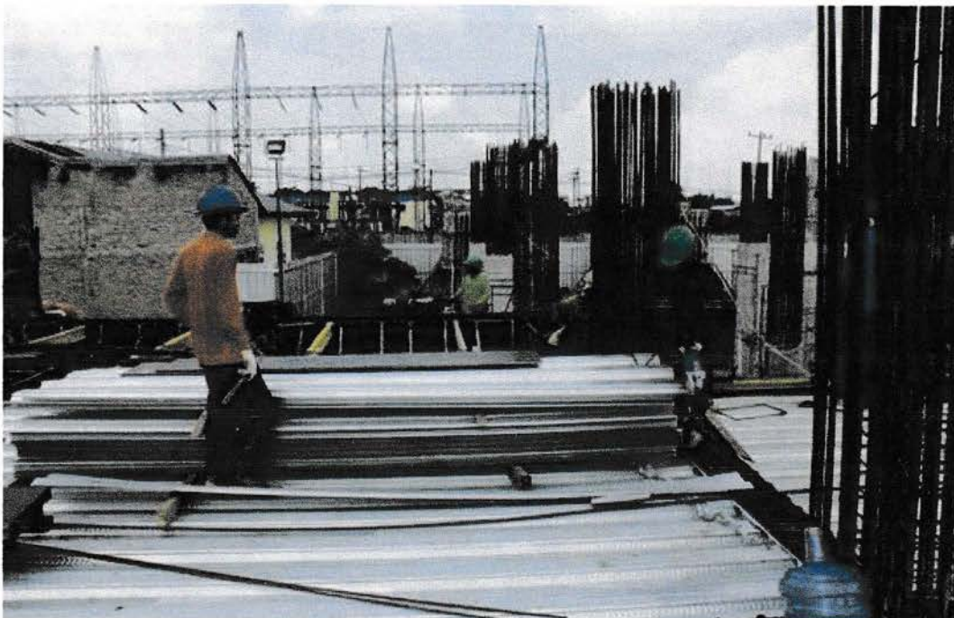
Gambar 2 : Pemasangan wiremesh lantai
