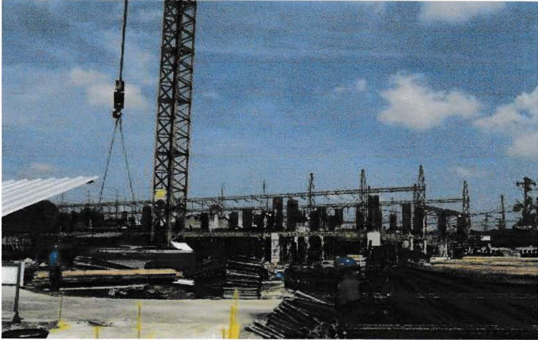
Gambar 1 : Tampak struktur gedung
