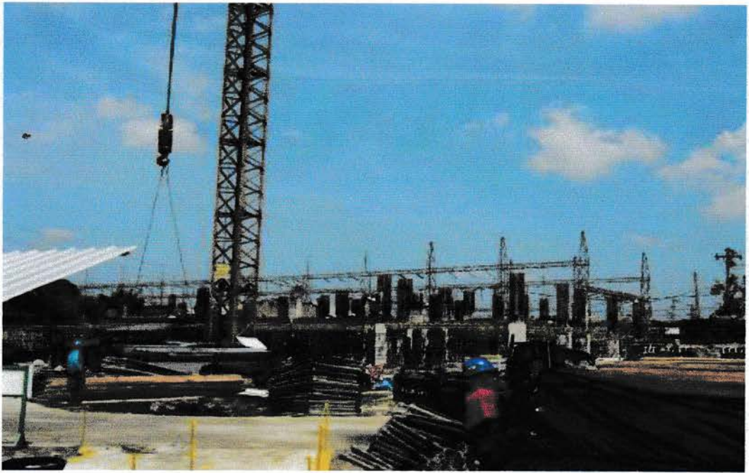
Gambar 1 : Tampak struktur gedung
