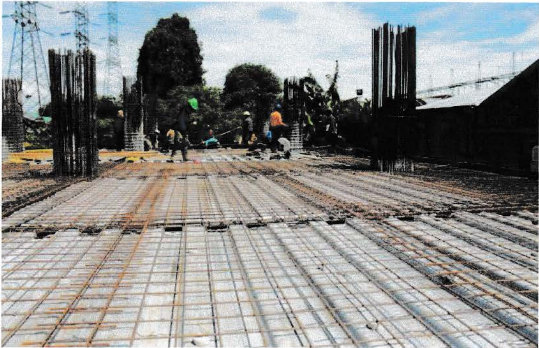
Gambar 3 : Pasangan wire mash
