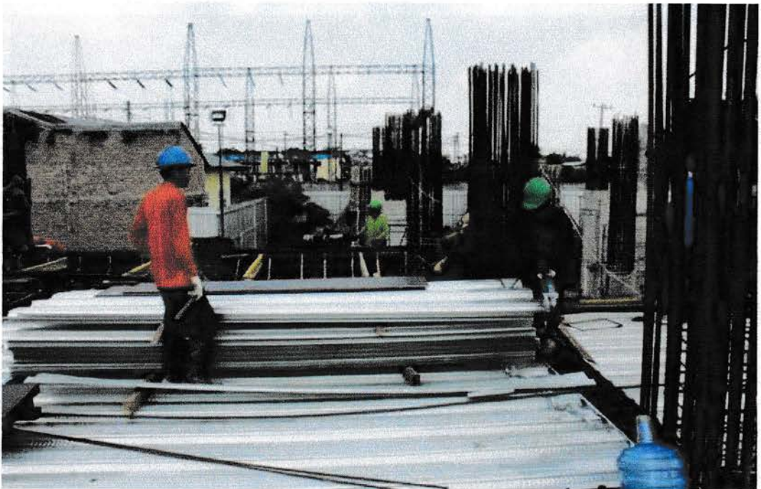
Gambar 2 : Pemasangan wiremesh lantai
