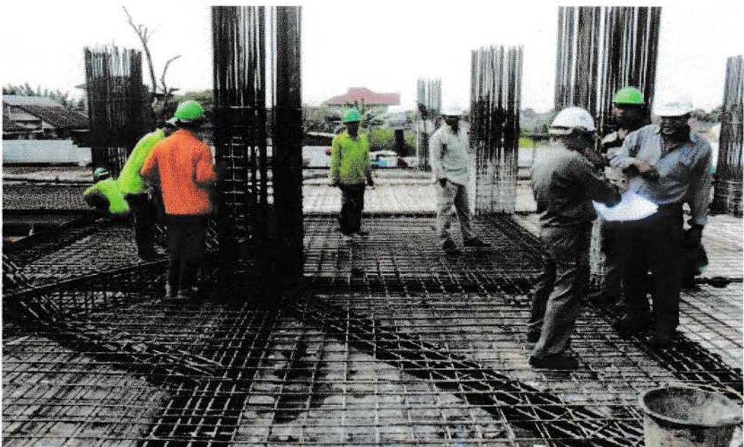
Gambar 8 : Pembesian Lantai 2 Gedung Kedokteran UISU
