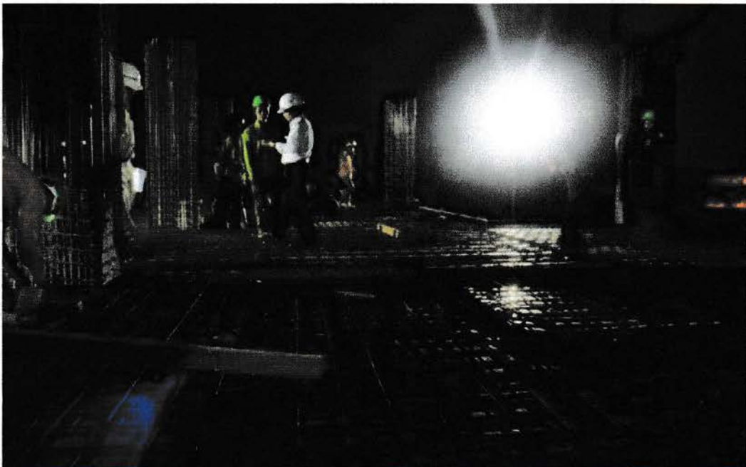
Gambar 6 : Persiapan Pengecoran Plat Lt.2
