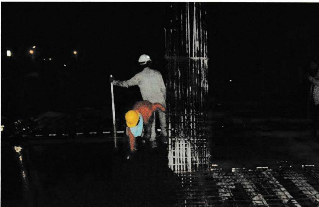
Gambar 4 : Pengecoran Plat lantai 2
