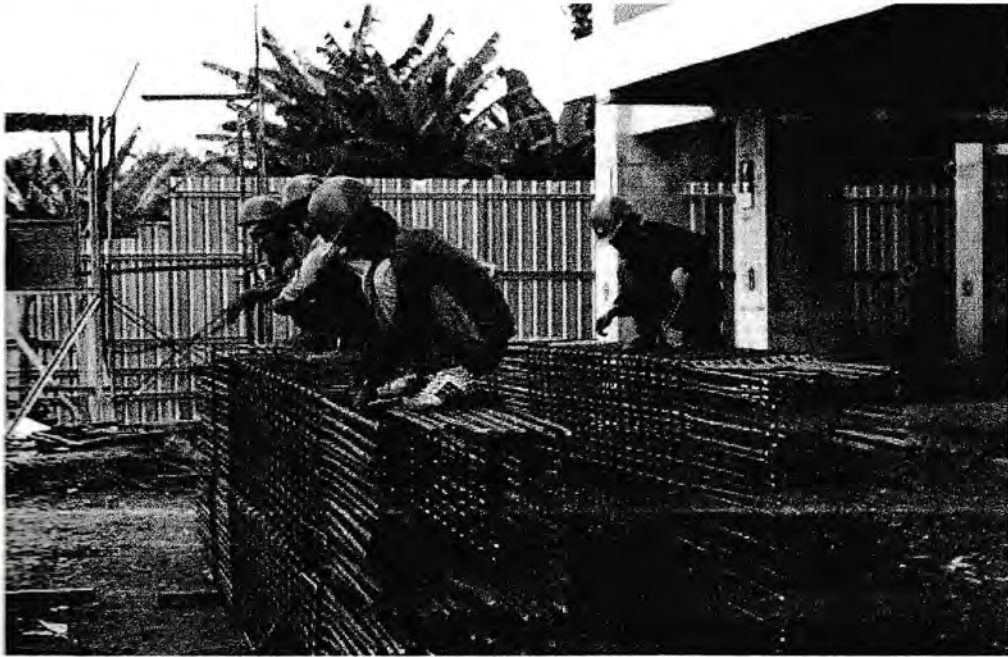
Gambar 2.9.6 Pembuatan Besi tulangan kolom
