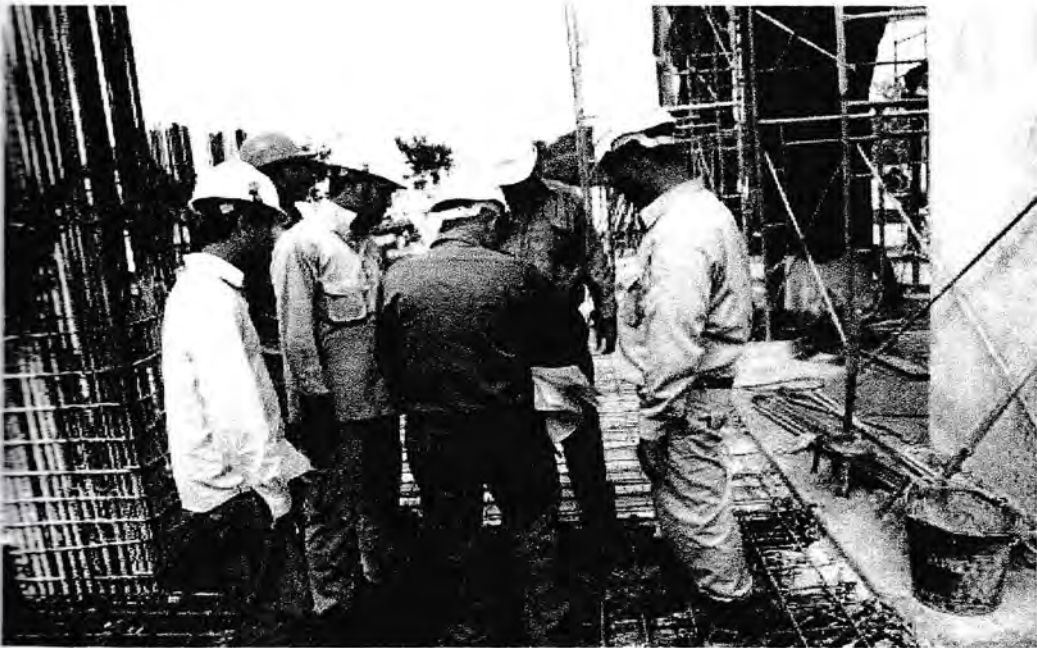
Gambar 10 : Ceklist Pekerjaan Sebelum Pengecoran
