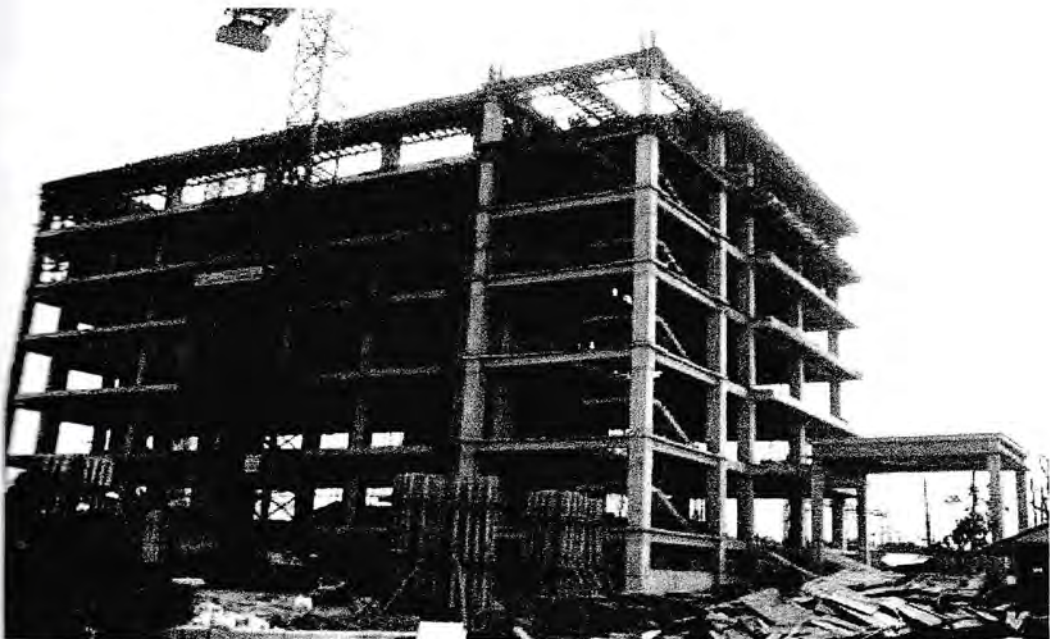
Gambar 26 : Tampak Struktur gedung
