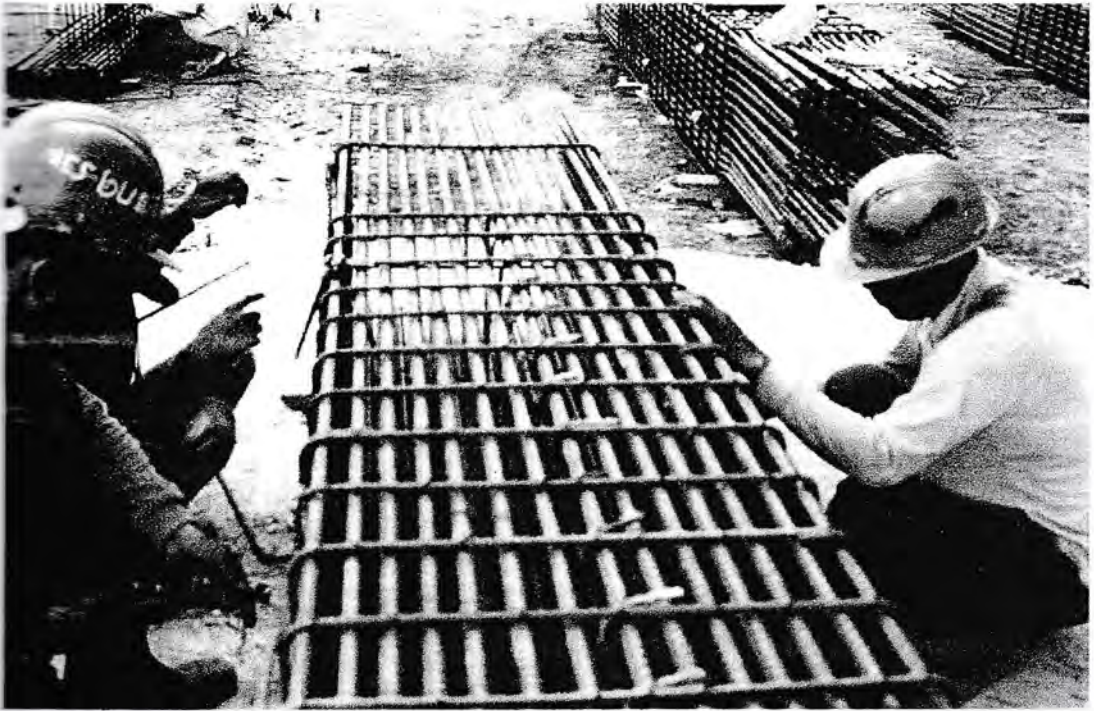
Gambar 25 : Pembesian Kolom
