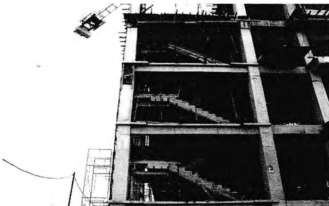
Gambar 20 : pasangan tangga tiap lantai
