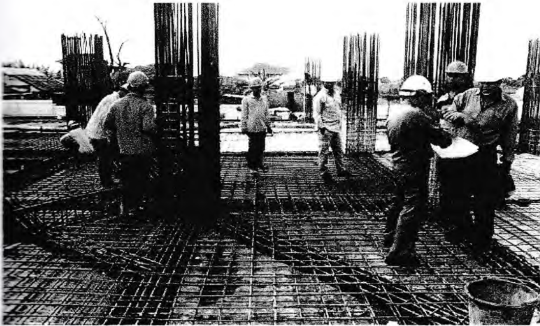
Gambar 8 : Pembesian Lantai 2 Gedung Kedokteran UISU
