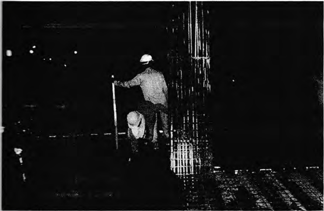
Gambar 4 : Pengecoran Plat lantai 2
