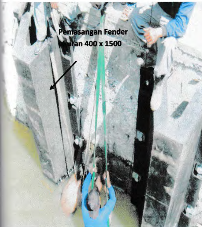
Pemasangan Fender 400 x 1500
