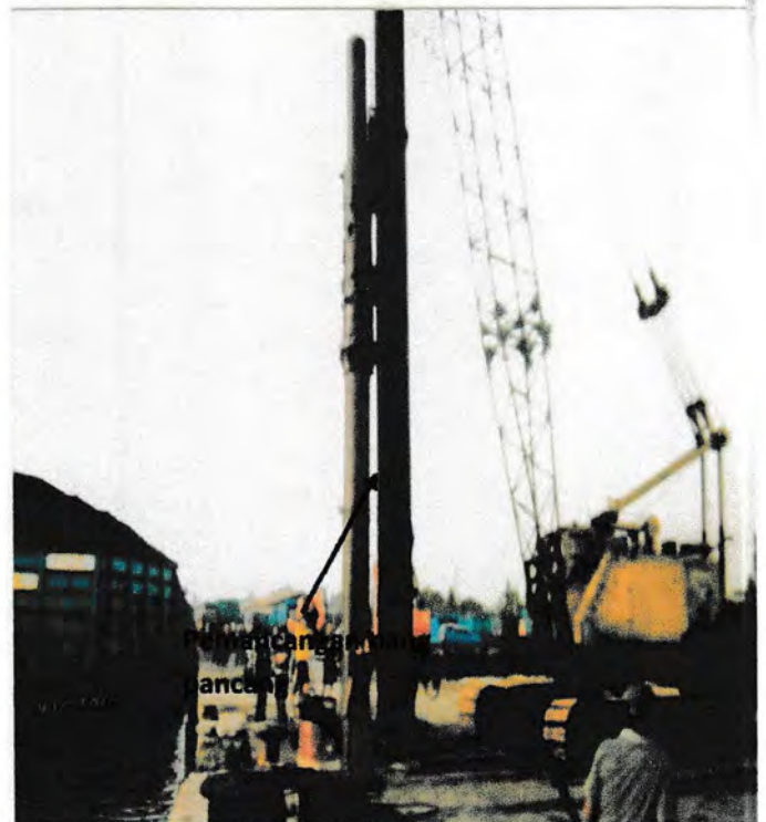
Tiang pancang di pancang menggunakan diesel hammer
