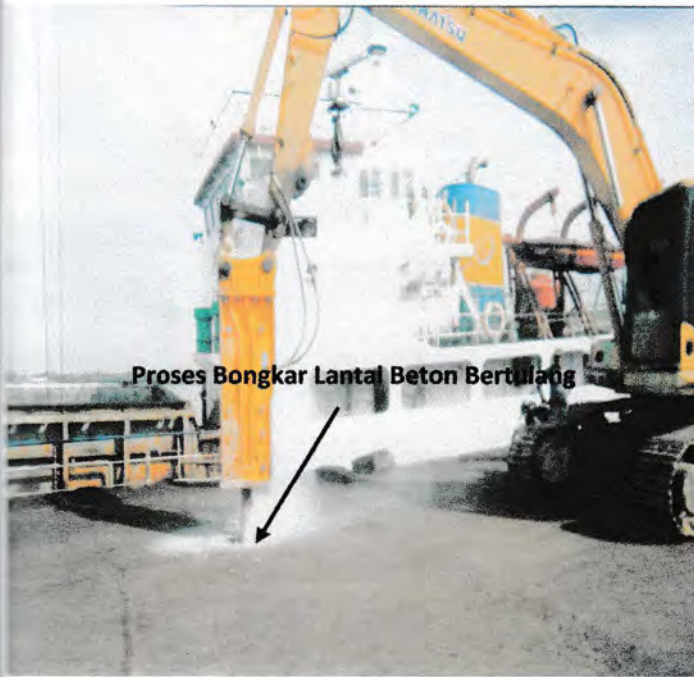
Proses Bongkar Lantai Beton Bertulang
