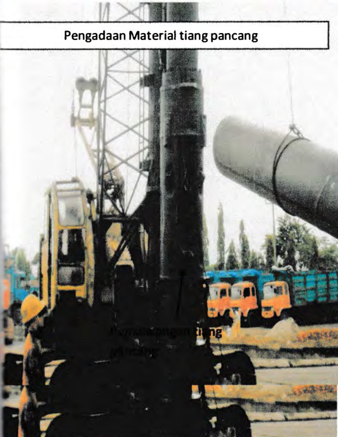
Pemancangan tiang pancang baja
