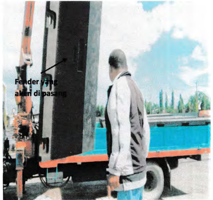
Proses pemasangan fender
