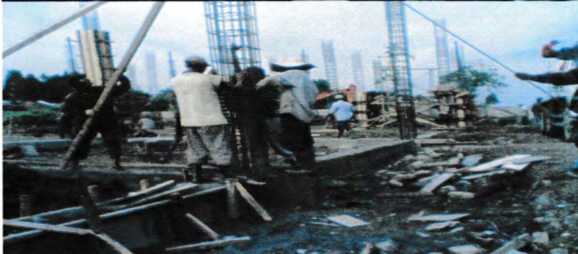
Proses perakitan dan penegakan tulangan kolom
