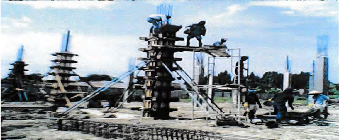
Pemasangan bekisting dan pelaksanaan pengecoran kolom
