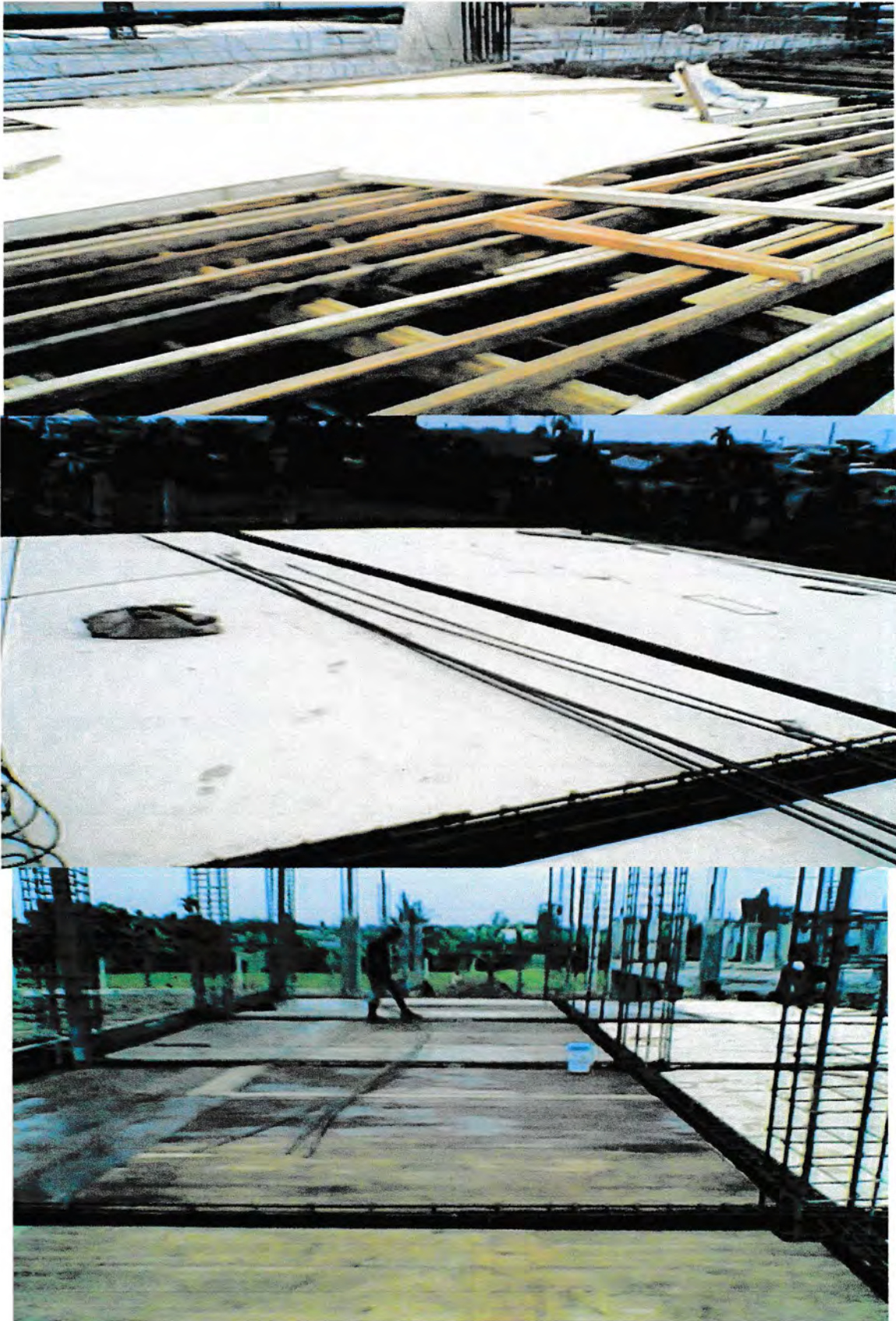
Pemasangan bekisting pada plat lantai
