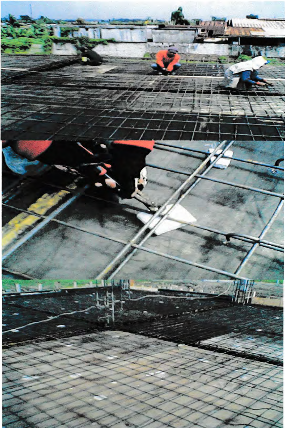
Pemasangan tulangan dan selimut beton pada plat lantai
