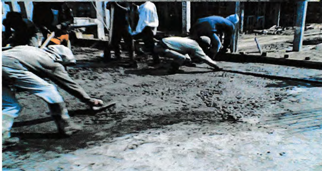
Pelaksanaan pengecoran plat lantai
