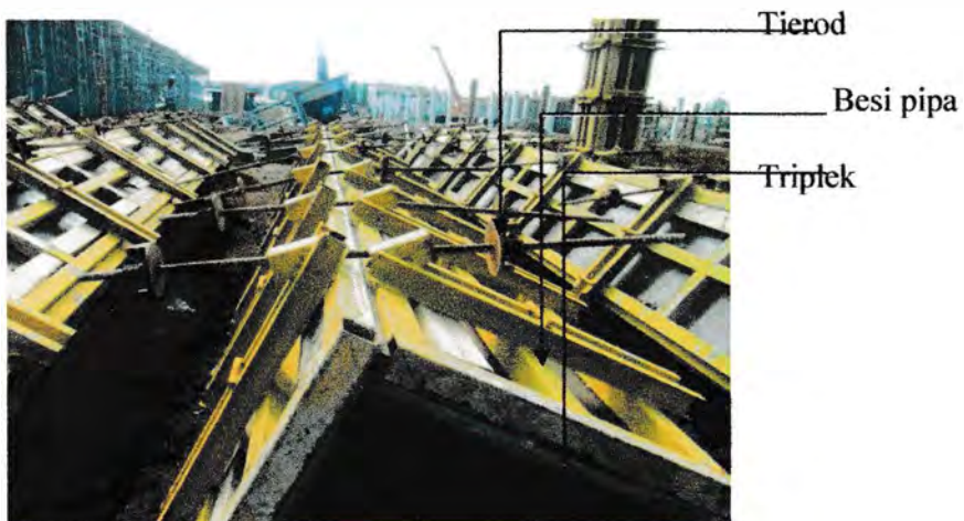
Gambar 2.1a : bekisting kolom (sumber dari lapangan)
