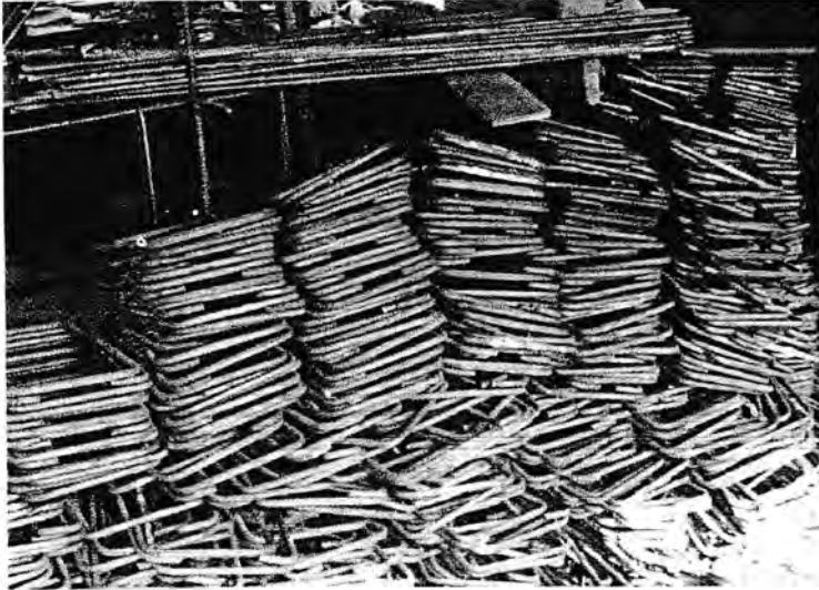
Gambar 3 Hasi Pembengkokan besi tulangan
