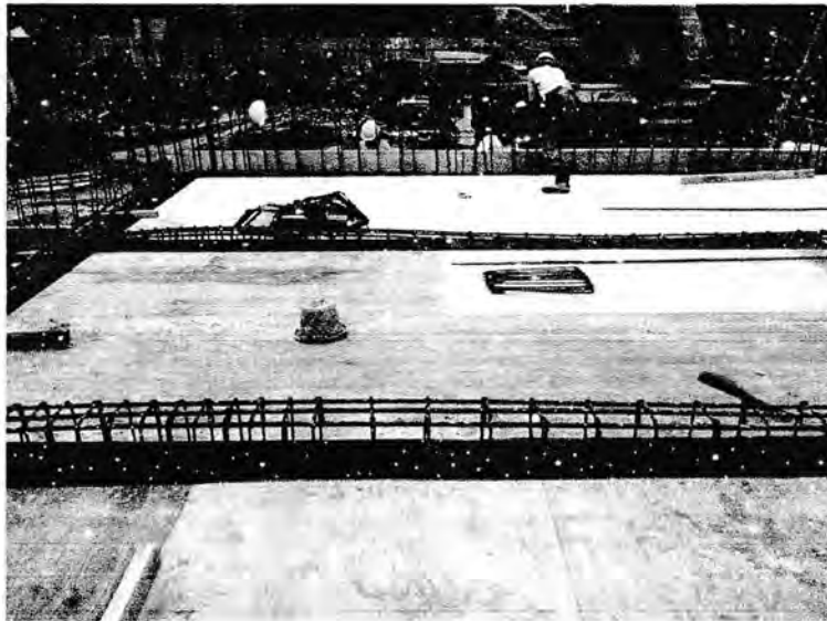
Gambar 3.13 Pemasangan Bekisting Balok dan Plat Lantai
