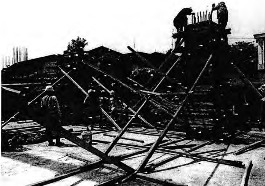
Gambar 3.14 Bekisting kolom
