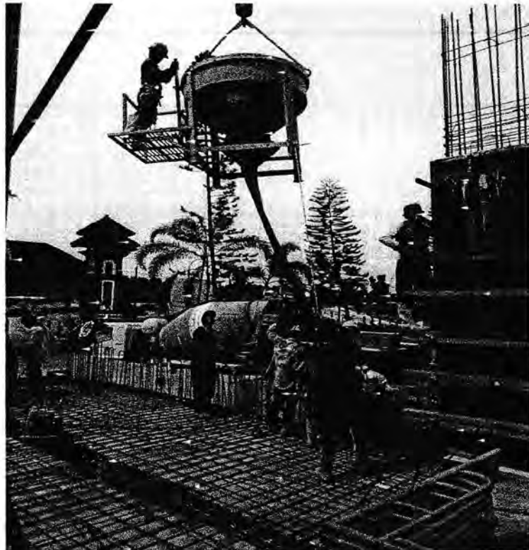
Gambar . Proses Pengcoran Kolom
