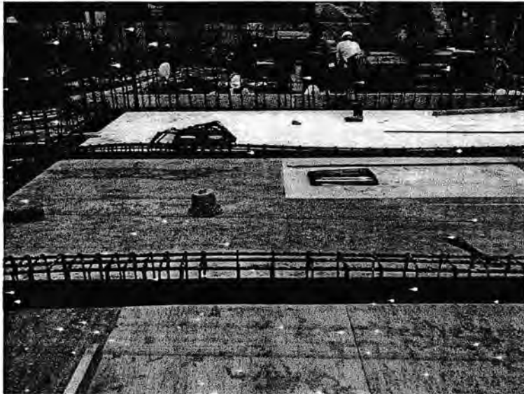
Gambar 3.11 Pemasangan Bekisting Balok dan Plat Lantai
