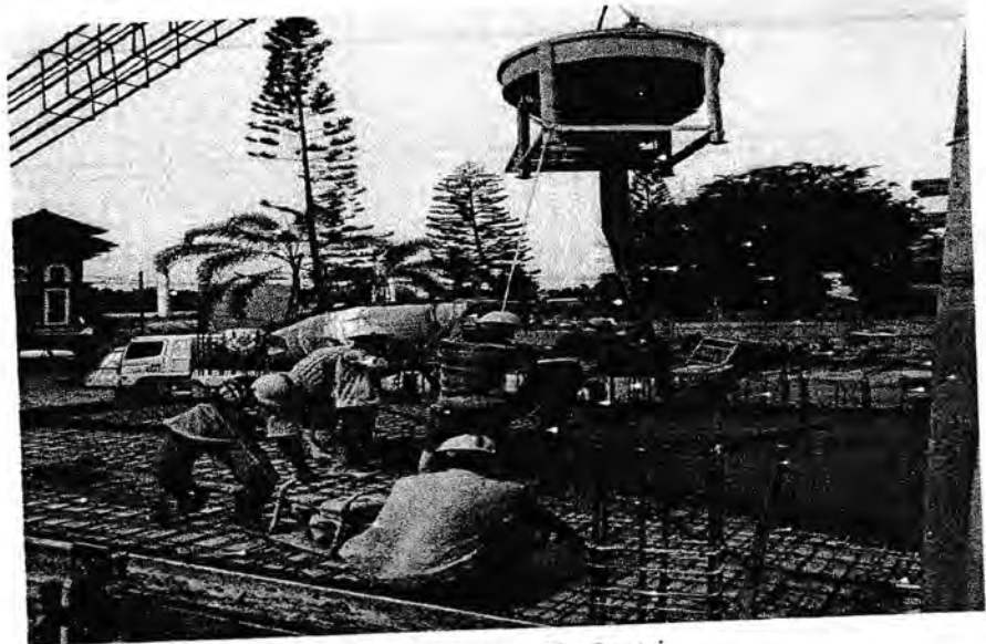
Gambar. Pengecoran Plat Lantai Lokasi : Jalan william iskandar, Pancing
