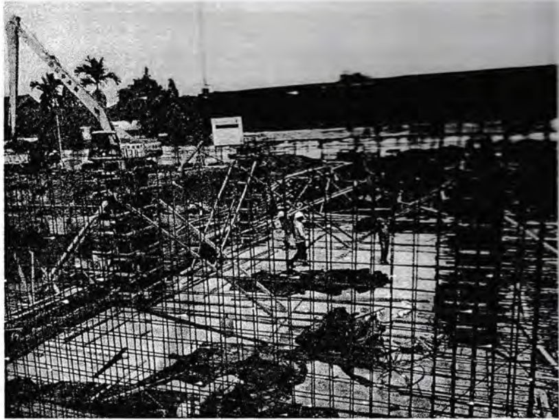
Gambar. Proses Pengeringan Kolom Lokasi : Jalan william Iskandar, Pancing
