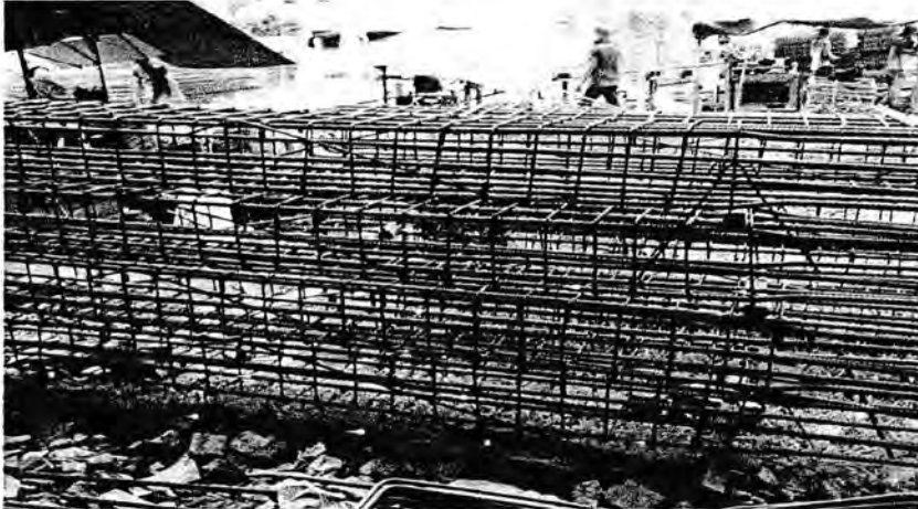
Gambar 3.17 Pekerjaan pemotongan dan pembengkokan tulangan
