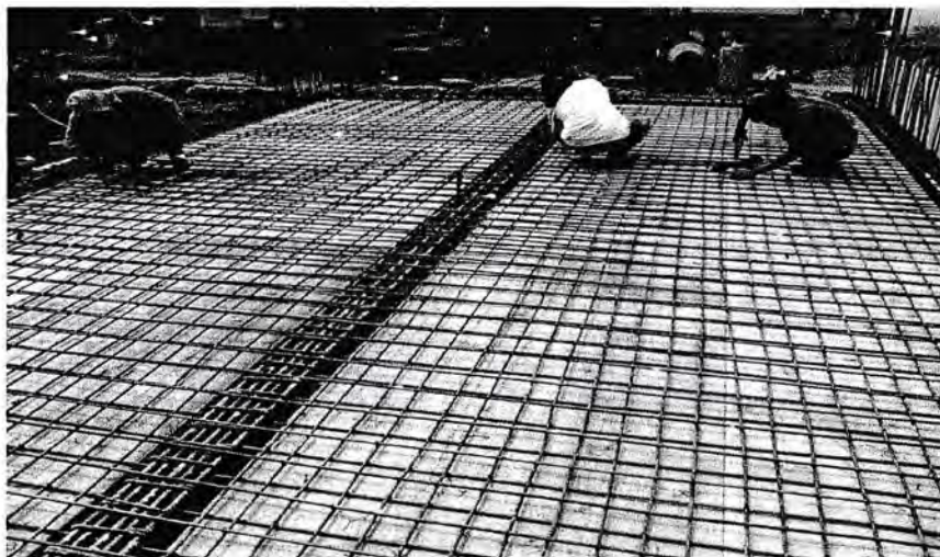
Gambar 3.20 Tulangan plat lantai
