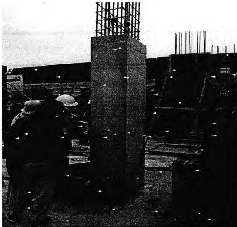
Gambar. Kolom Selesai Lokasi : Jalan william iskandar, pancing
