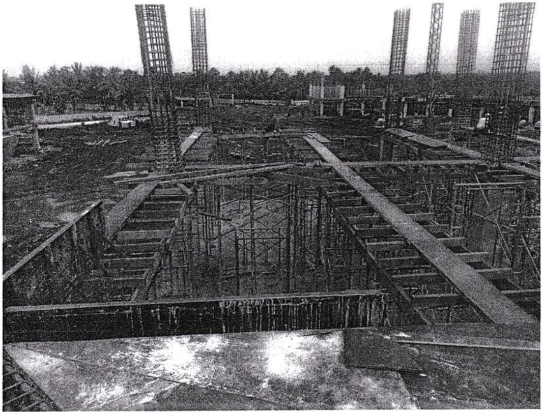
Gambar3 :Pemasangan Bekisting Balok Lantai 3
