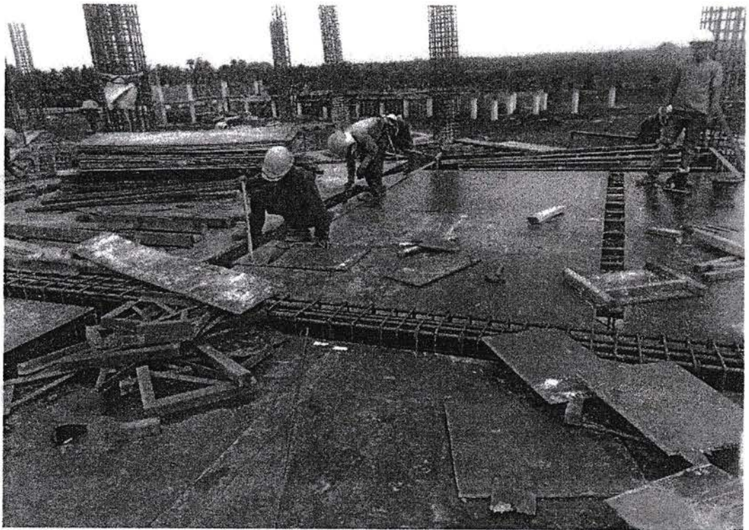
Gambar 3.17 Pekerjaan Pembesian Balok
