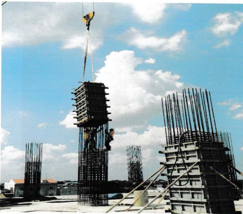
Gambar 4 : Pemasangan bekisting
