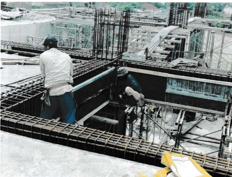
Gambar 9 :Pemasangan bekisting untuk balok
