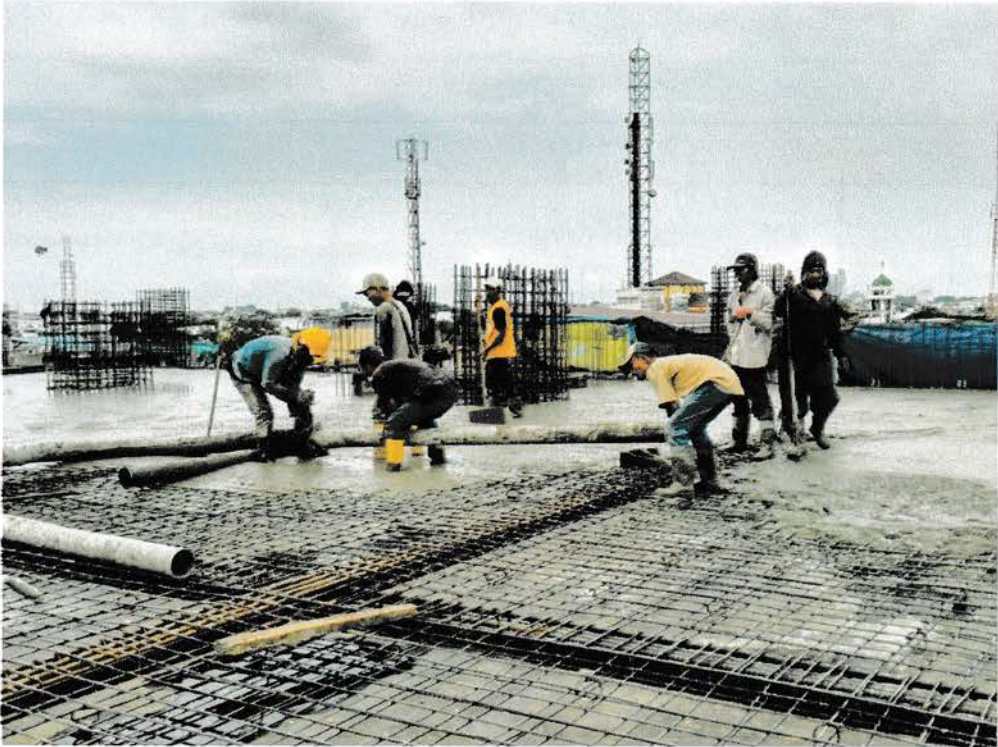
Gambar 12 : Pengecoran plat lantai dan balok
