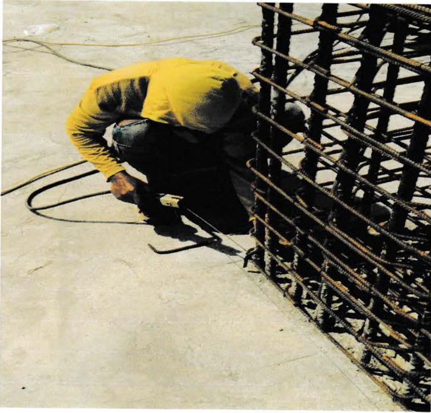
Gambar 3 : Pemasangan sepatu tiang kolom
