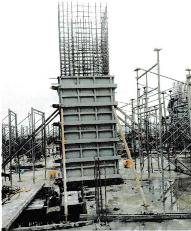
Gambar 5 : Bekisting kolom
