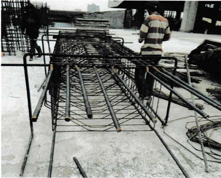
Gambar 1 : Pemasangan tulangan dan begel kolom
