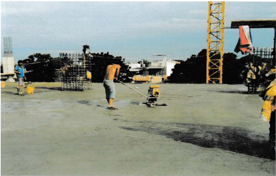
Gambar 13 : Pekerjaan akhir dari pengecoran plat lantai dengan trowel
