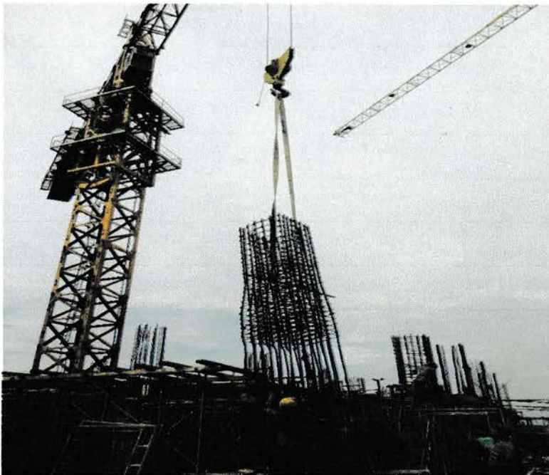
Gambar 2 : Pemasangan sambungan kolom
