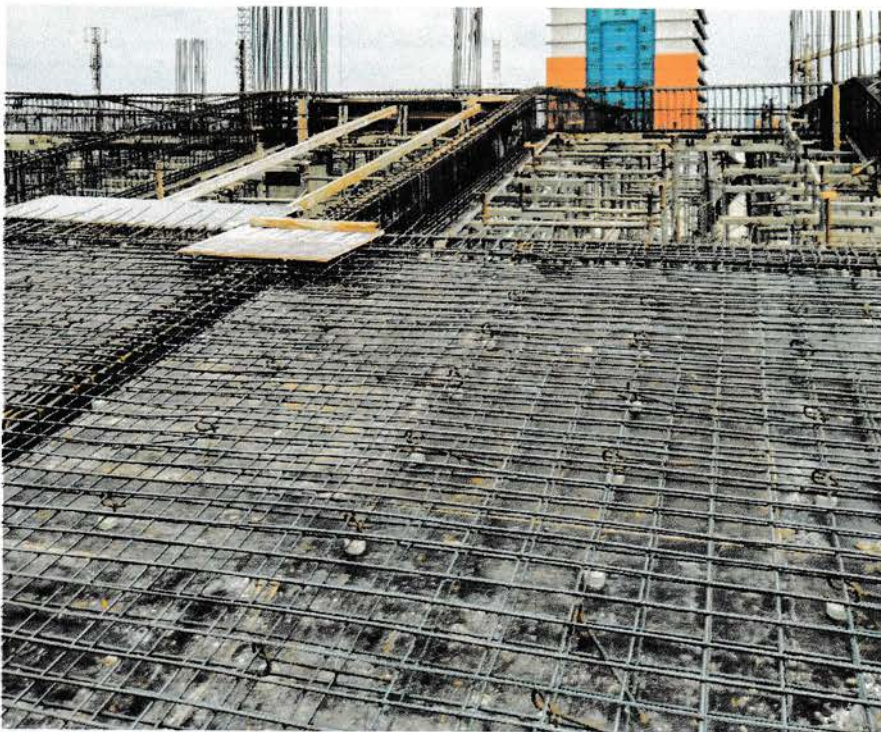
Gambar 11 : Pemasangan penulangan plat lantai dengan decking dan cakar ayam
