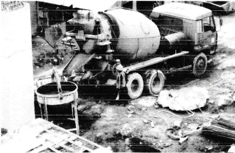
Gambar 2.10 pengangkutan beton
