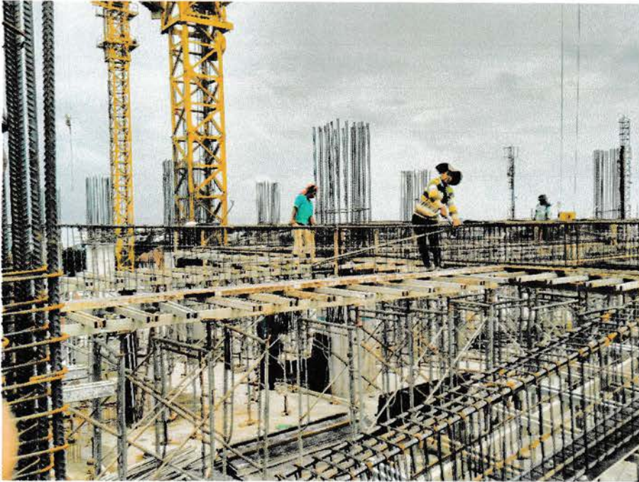
Gambar 8 :Pemasangan Tulangan dan begel pada balok
