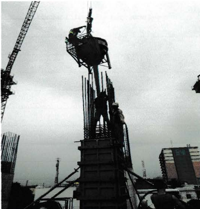
Gambar 6 : Pengecoran kolom
