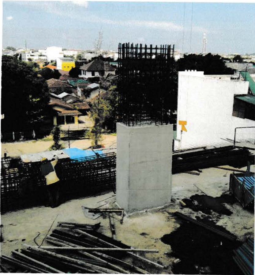
Gambar 7 : Hasil akhir pengecoran kolom
