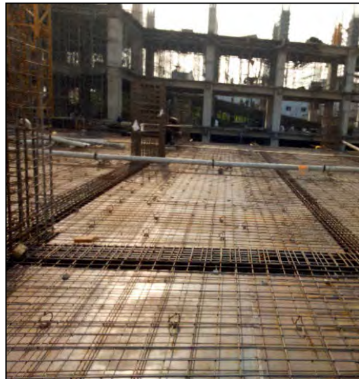
. Gambar 2.23 (e) Pemasangan Tulangan
