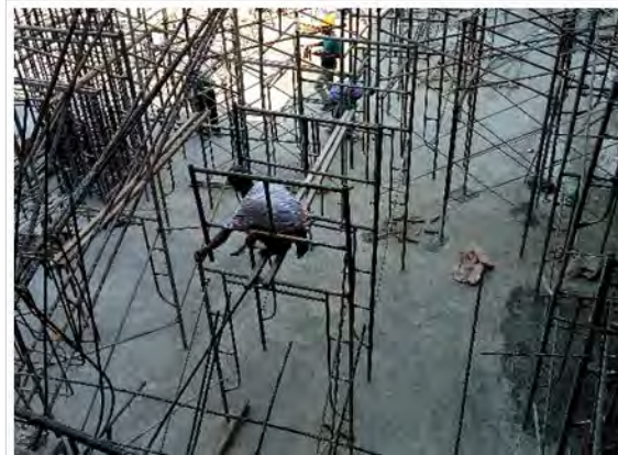
Gambar 2.23 (a) Pemasangan Perancah
