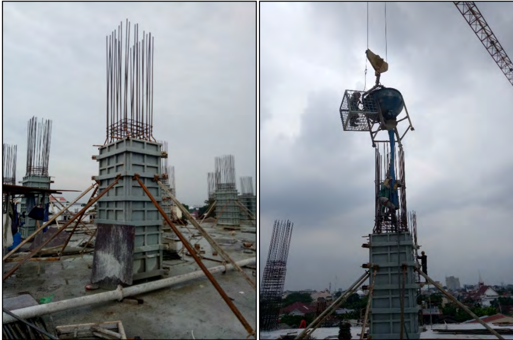
Gambar 2.22 Pemasangan bekisting dan pengecoran
