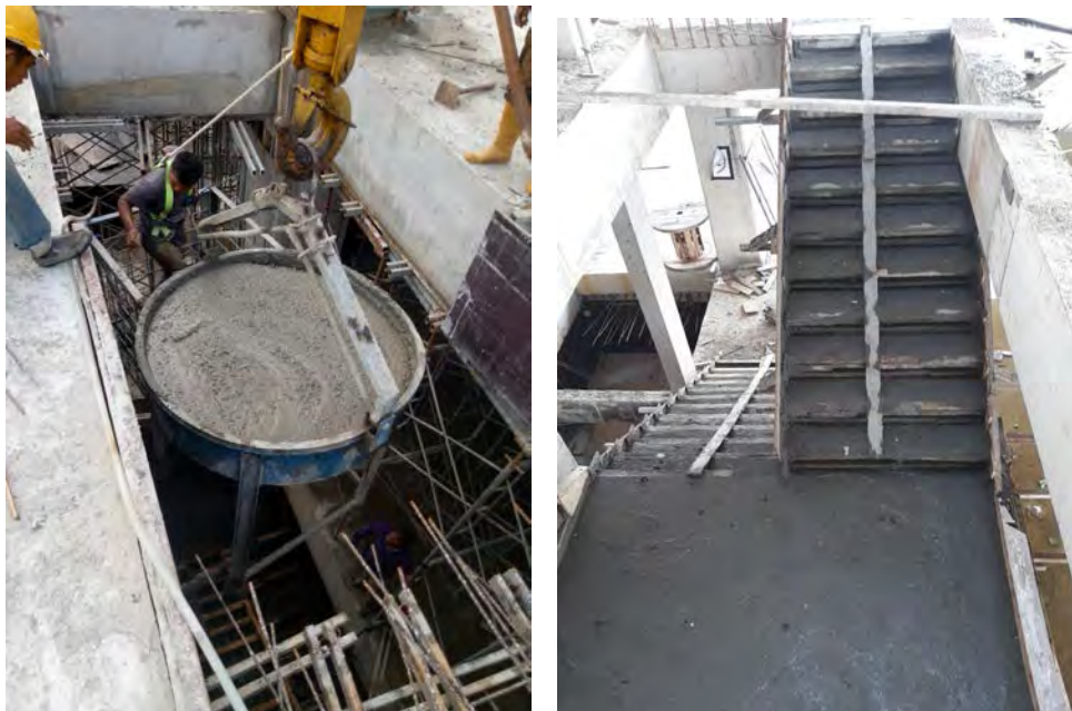
. Gambar 2.24 Pengecoran pelat lantai
