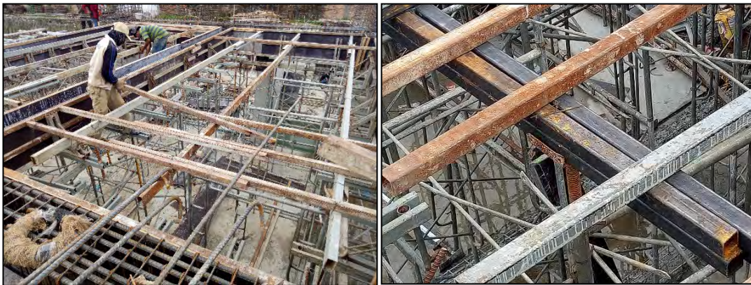
a. Gambar 2.23 (b) Pemasangan U-Head dan Penampang
