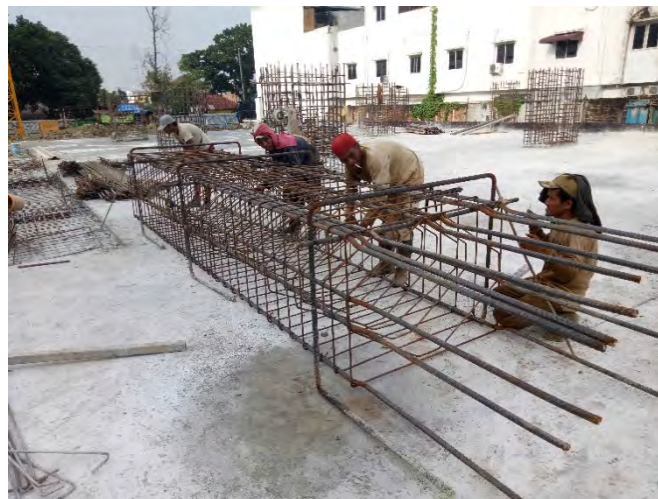
Gambar 2.21 Penulangan Kolom
