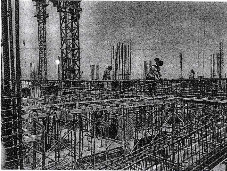
Gambar 8 :Pemasangan Tulangan dan begel pada balok
