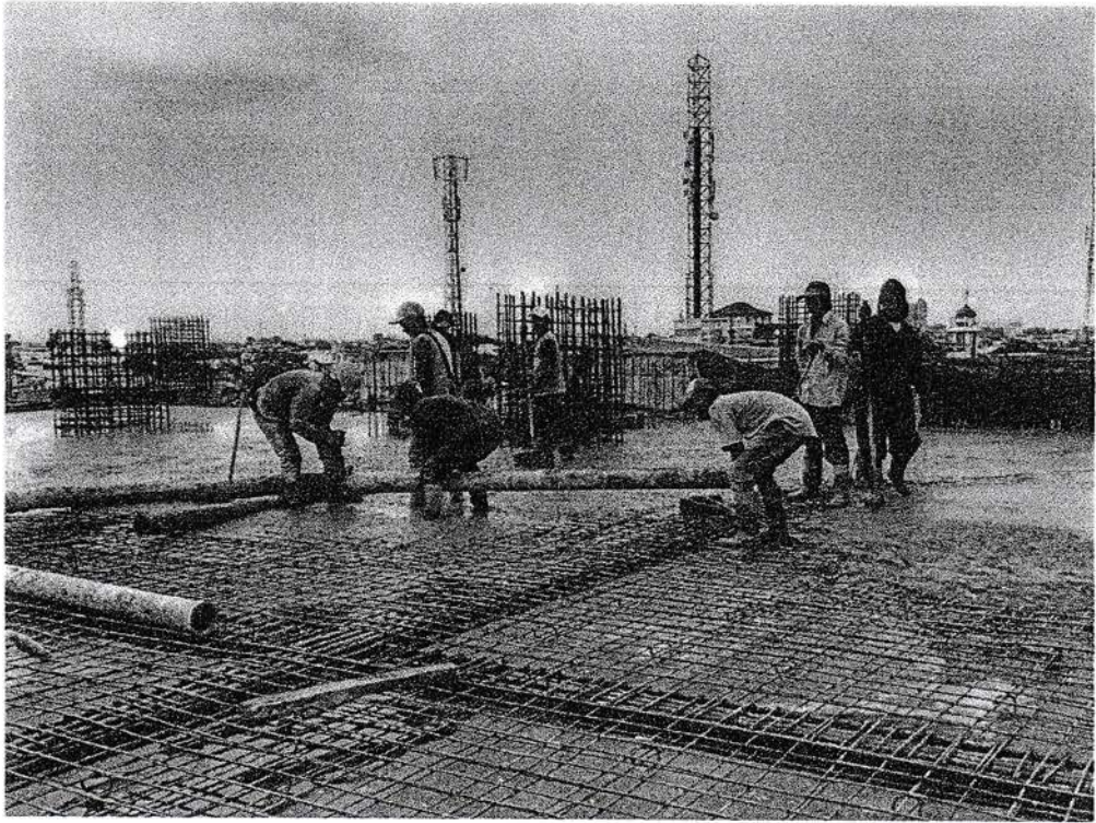
Gambar 12 : Pengecoran plat lantai dan balok
