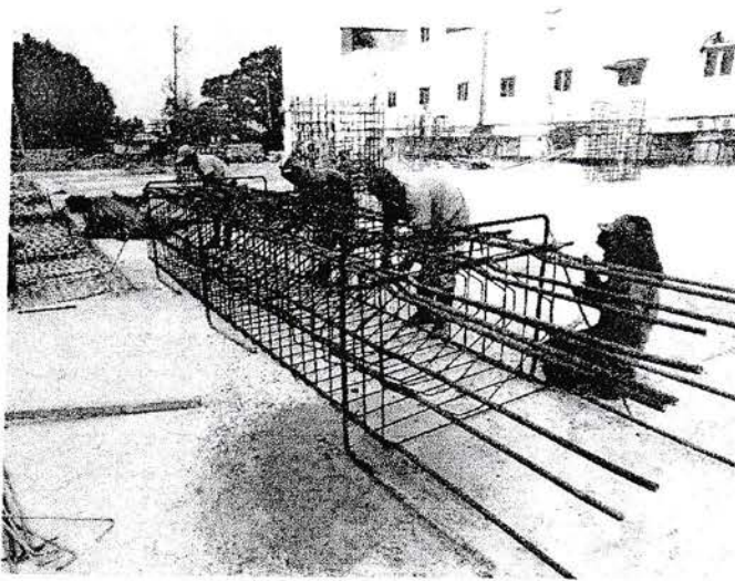
Gambar 2.21 Penulangan Kolom
