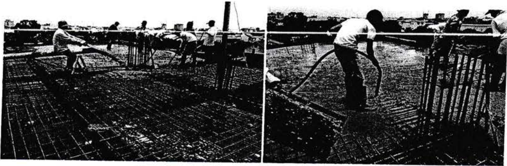
Gambar 2.11 Pengecoran pada Pelat
