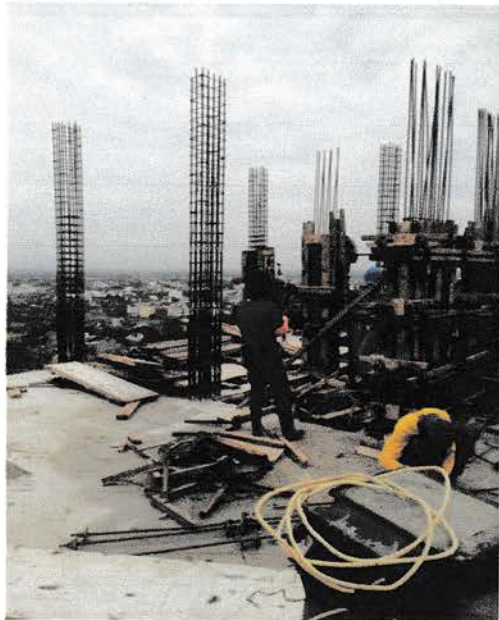
Gambar: Penulangan Kolom
