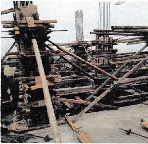
Gambar: Bekisting Kolom
