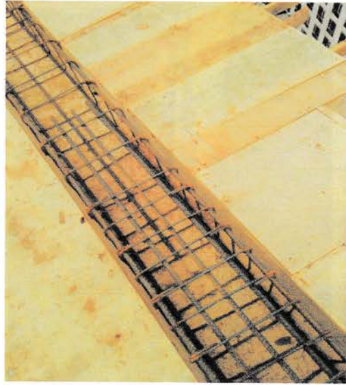
Gambar: Penulangan Balok
