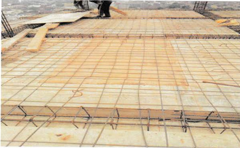
Gambar 3.19 : Pekerjaan Plat Lantai
