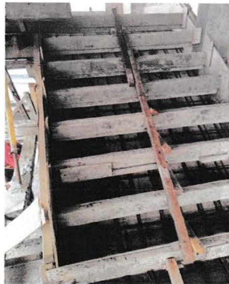
Gambar : Penulangan Tangga
