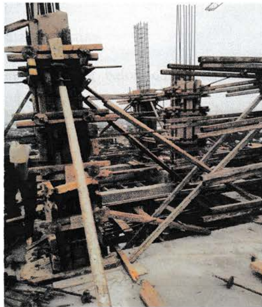
Gambar 3.2 : Bekisting Kolom
