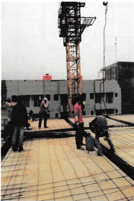
Gambar: Penulangan Pelat Lantai
