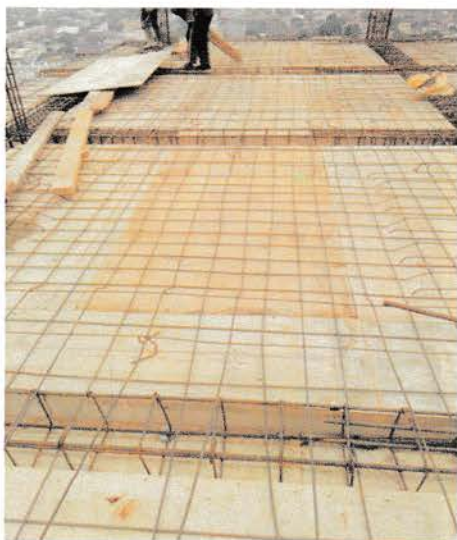
Gambar : Penulangan Pelat Lantai
