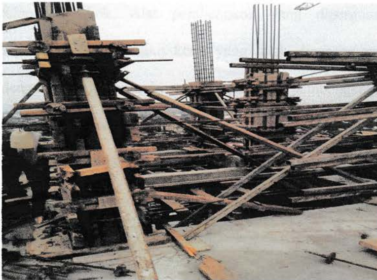
Gambar 3.18 : Pekerjaan Pemasangan Bekisting
