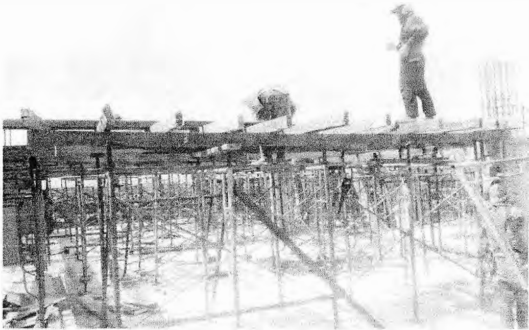
Gambar : Bekesting Balok Dan Plat Lantai
