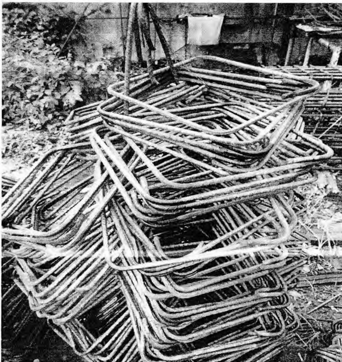
Gambar : Besi yang Selesai DiKerjakan
