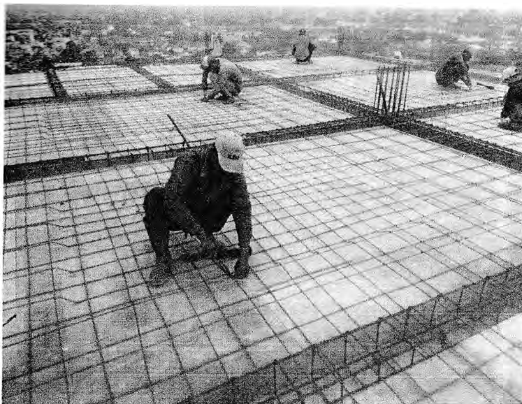
Gambar : Perakitan Plat Lantai
