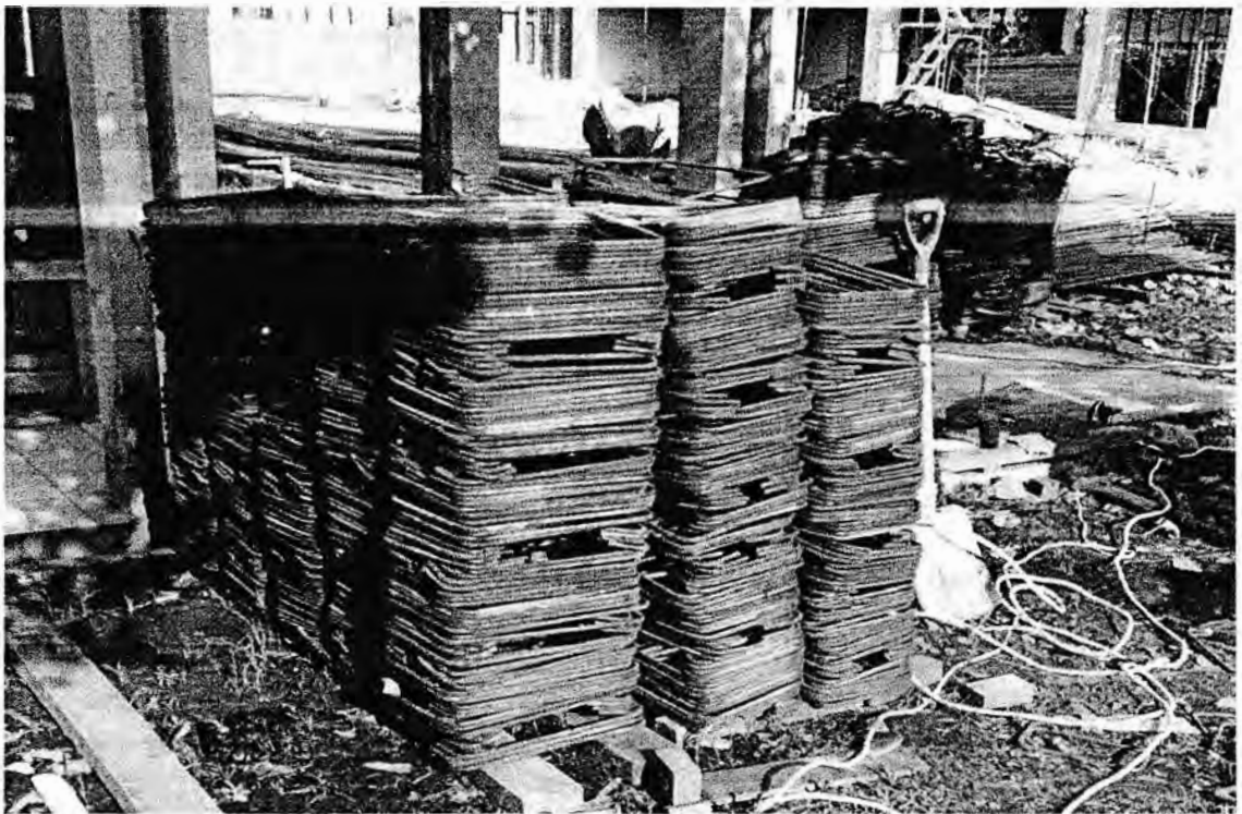
Gambar : Besi Sengkang yang Selesai Dikerjakan
