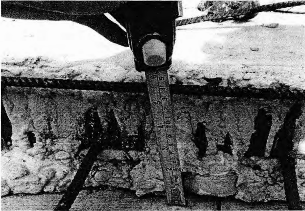
Gambar : Pengukuran Tebal Plat Lantai
