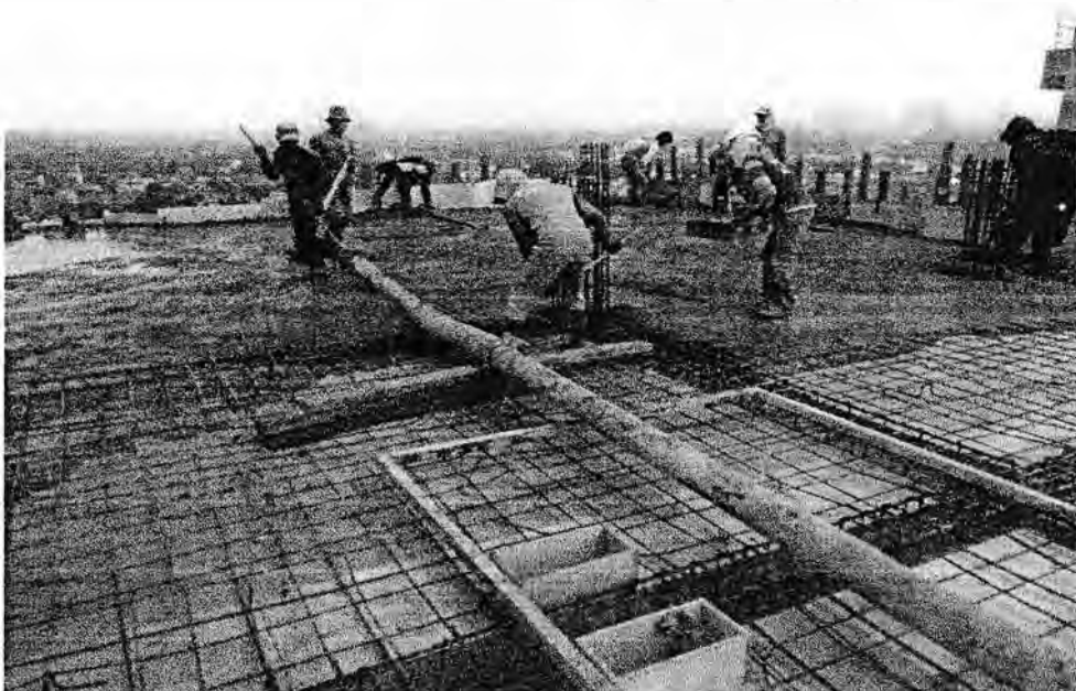
Gambar 3.15 Pengecoran Plat Lantai
