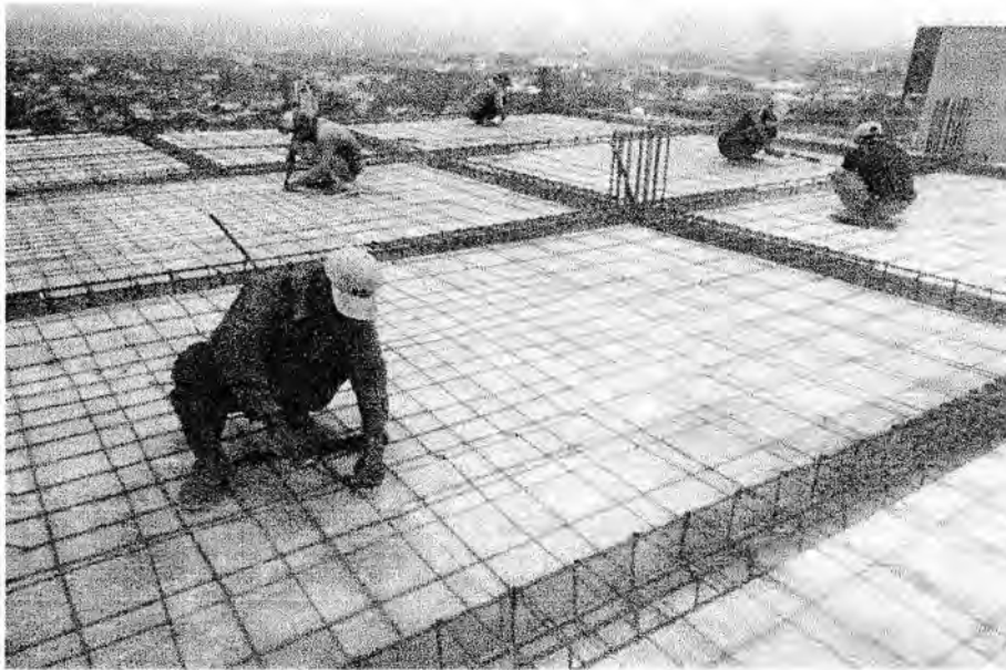
Gambar 3.14 Pembesian Plat Lantai
