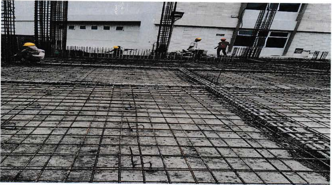
Gambar 3 : Penulangan Plat Lantai
