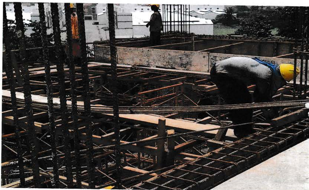
Gambar 2 : Pembuatan Bekisting Plat Lantai
