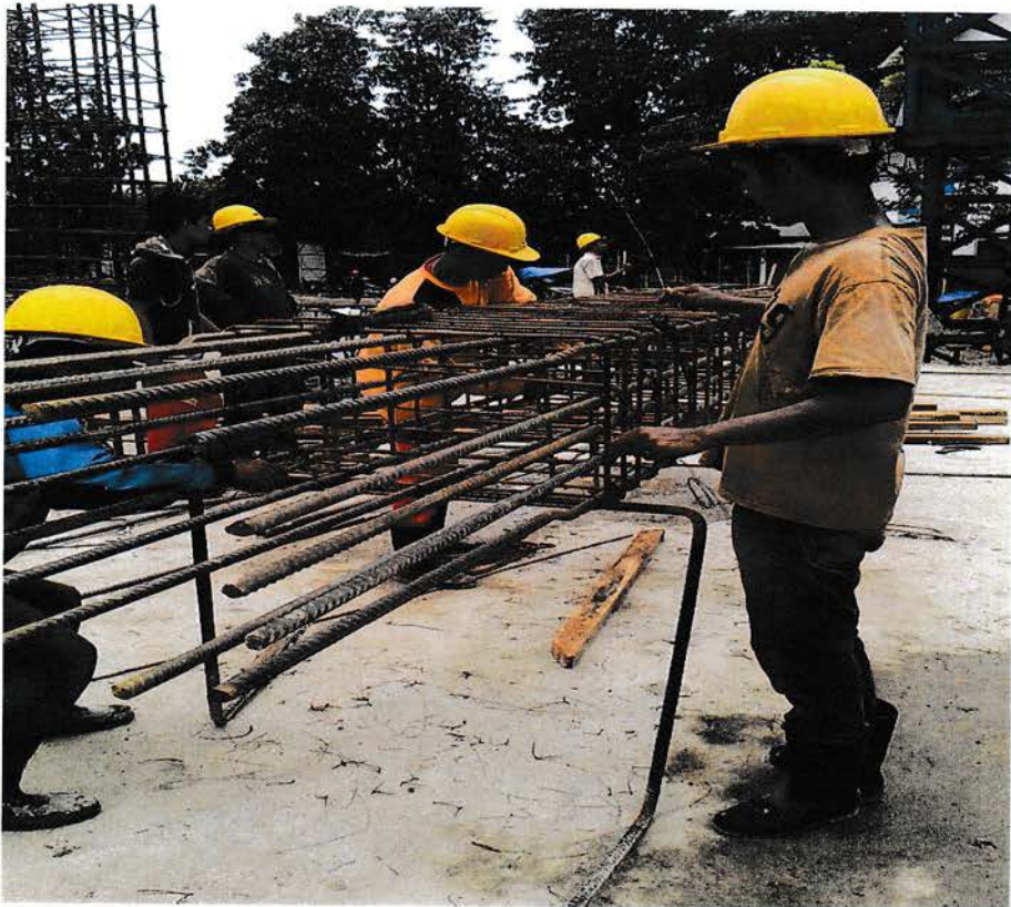
Gambar 4 : Pemasangan Besi Tulangan
