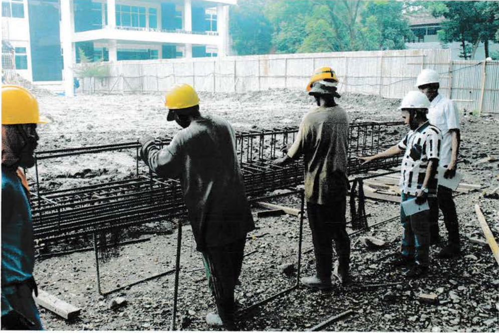
Gambar 2.9.6 Pembuatan Besi Tulangan Kolom
