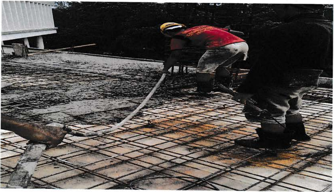
Gambar 5 : Pengecoran dan Pemasangan
