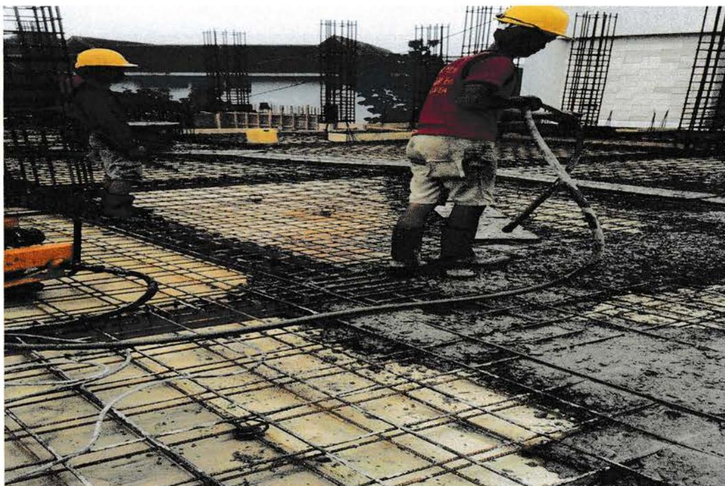
**Gambar : Pemasangan Beton dengan Vibrator**
