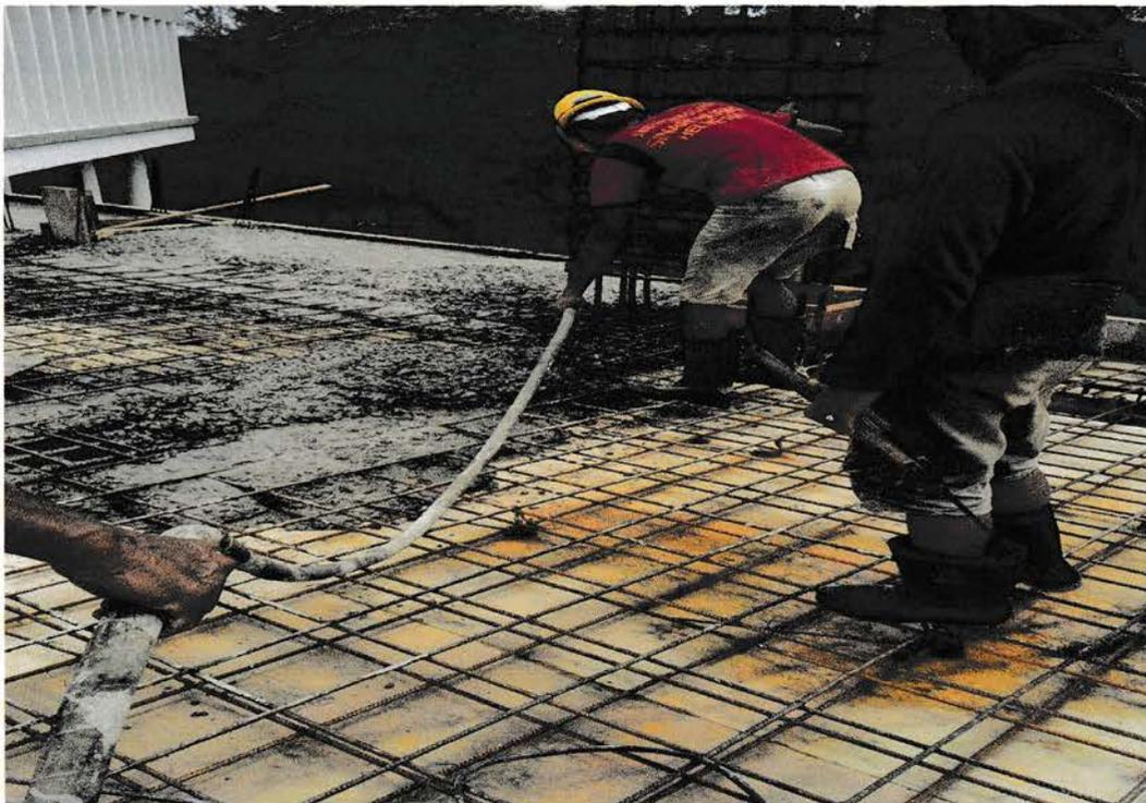
**Gambar : Pemasangan Beton dengan Vibrator**
