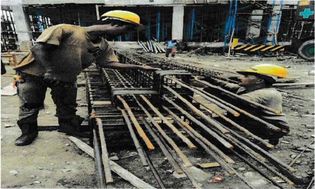
Gambar 2.5.2 Pembuatan Tulangan Kolom
