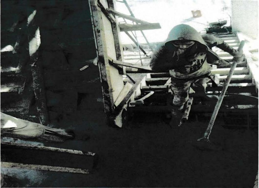
**Gambar 3.3 Pengecoran tangga**
