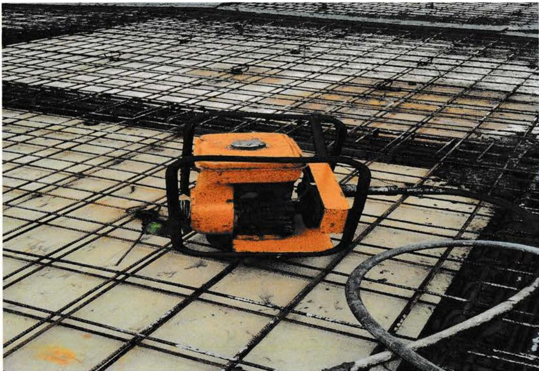
**Gambar : Mesin Vibrator**
