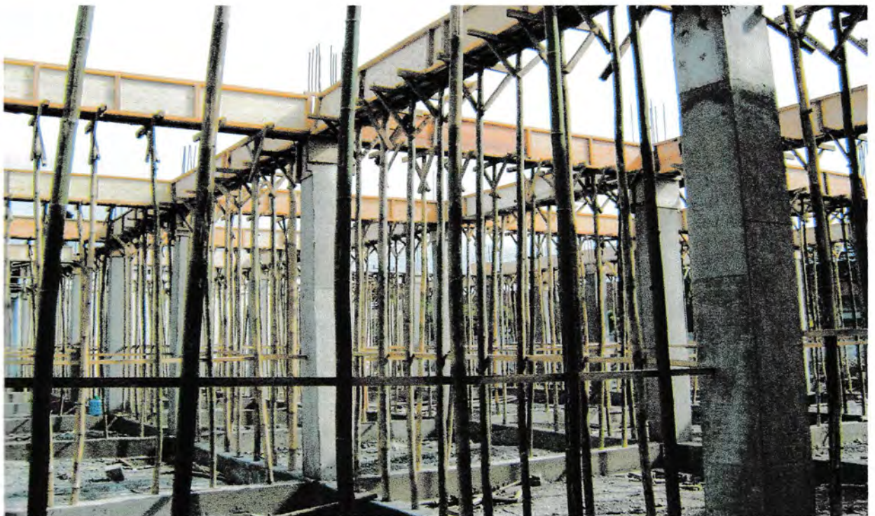
GAMBAR PEMASANGAN CETAKAN
