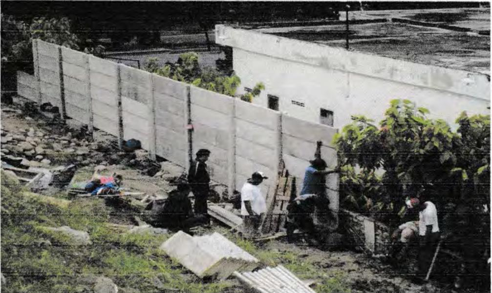
**Gambar 5.27 Pemasangan Pagar Tembok Beton**
