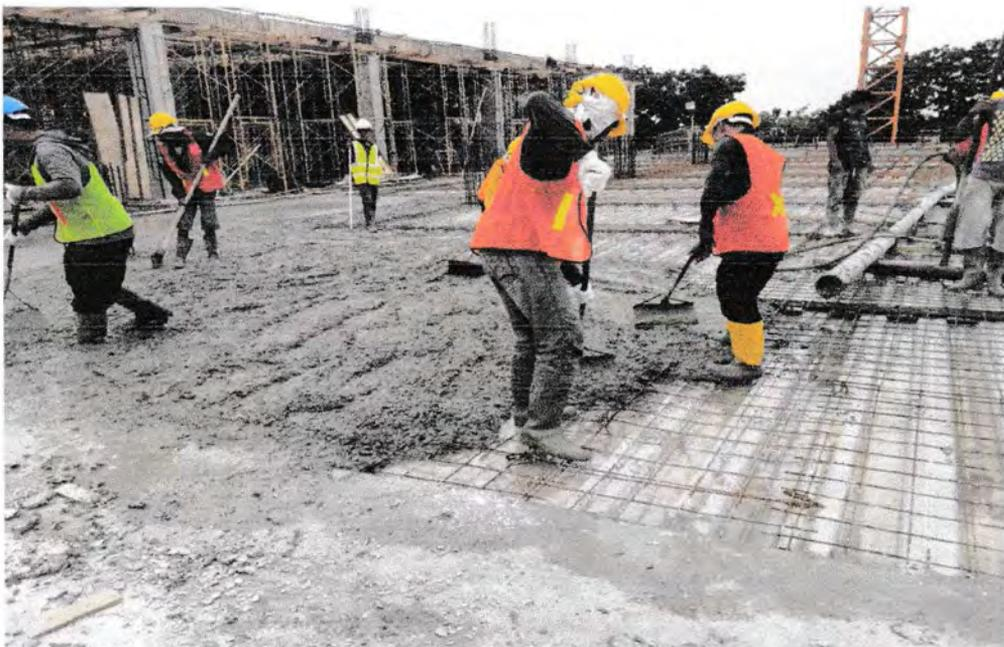
**Gambar 5.40 Pengecoran Plat Lantai dan Kolom**
