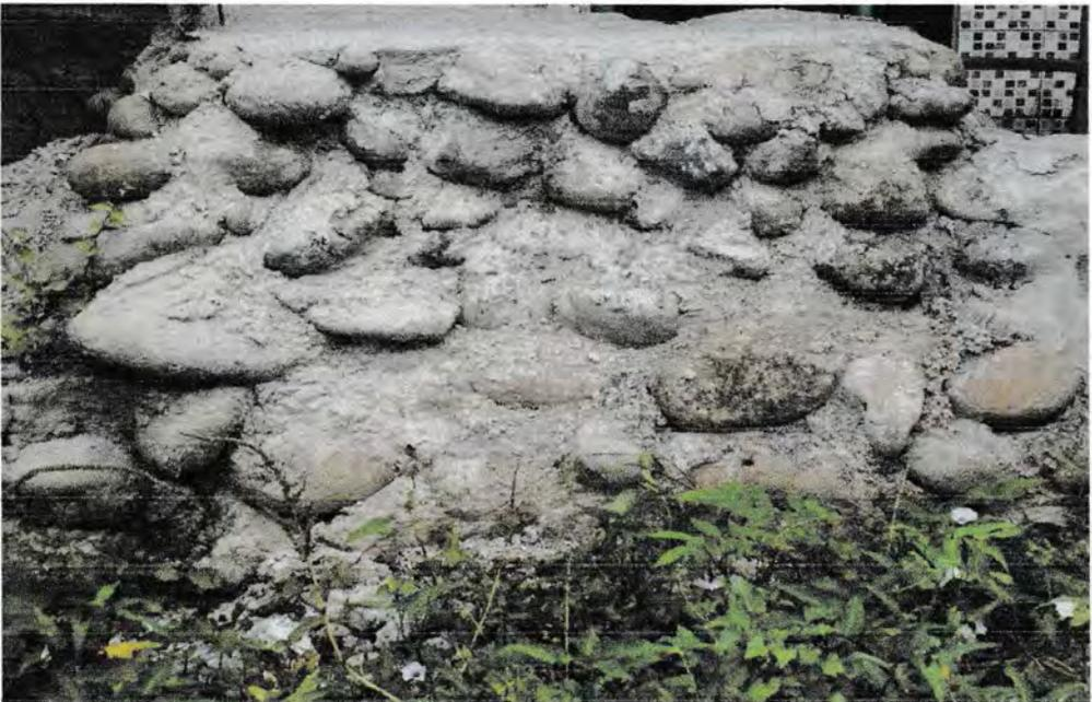
**Gambar 5.30 Pondasi Beton**
