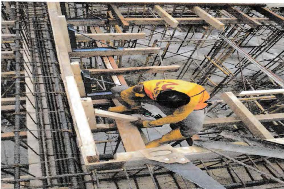
**Gambar 5.36 Pemasangan Siku Balok**
