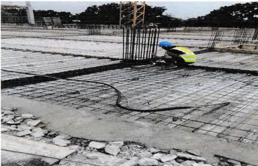
**Gambar 5.38 Pekerjaan Pemasangan Sepatu Kolom**
