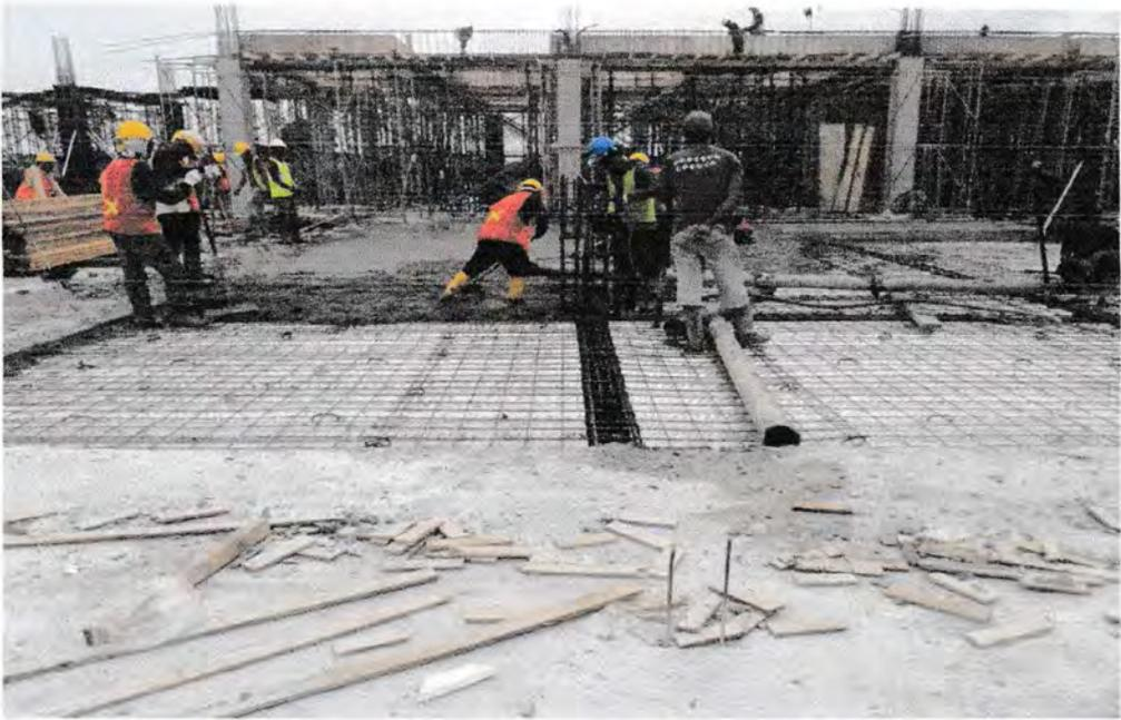
**Gambar 5.11 Pengecoran Plat Lantai**
