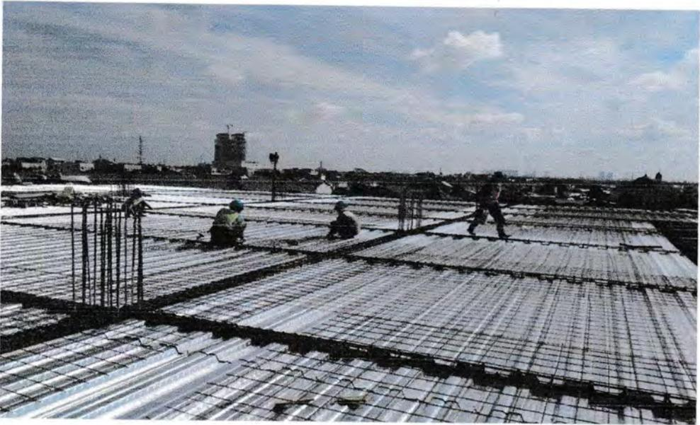
**Gambar 5.7 Pekerjaan Bekisting Plat Lantai**
