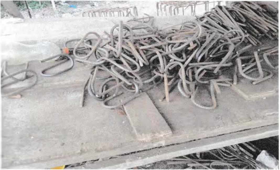
**Gambar 4.14** hasil pabrikasi dengan alat bae bending dan bae cutter
