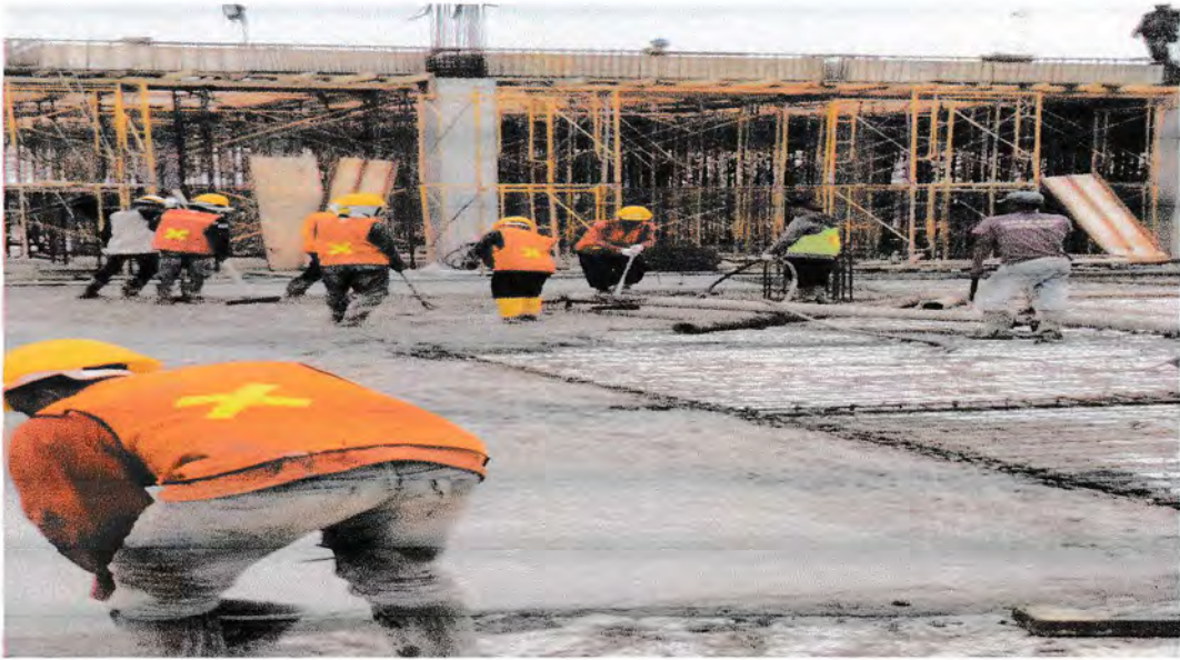
Gambar 5.5 Pengecoran Lantai
