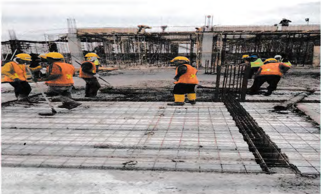
Gambar 5.4 Proses Pengecoran Plat
