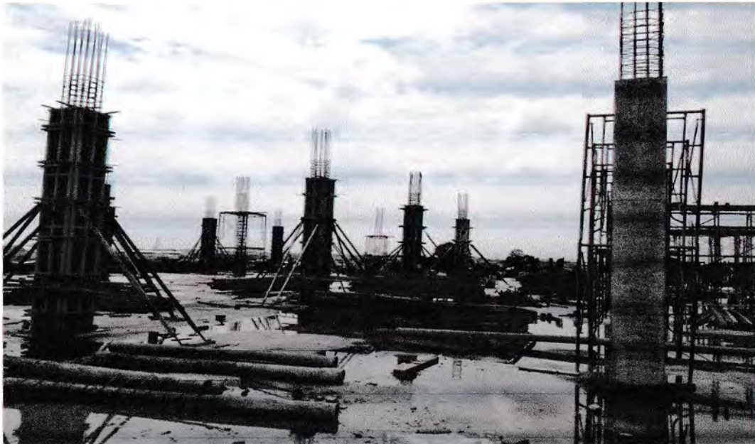
Gambar 5.6 Pemasangan Bekisting Kolom
