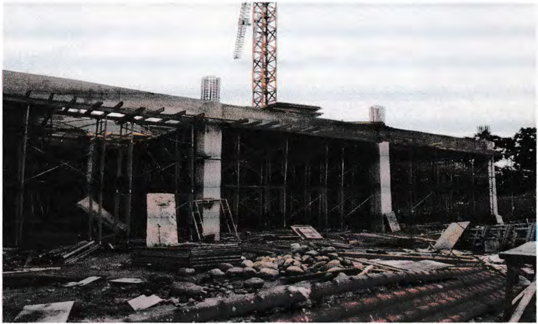
Gambar 5.1 Foto Tampang Samping Proyek
