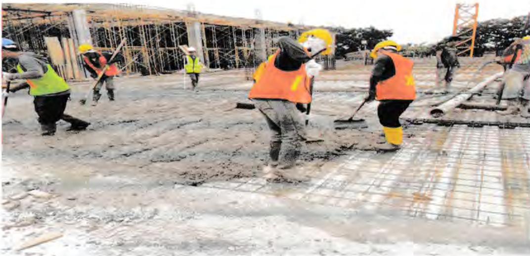
Gambar 3.2 Proses Pengecoran Beton Plat
