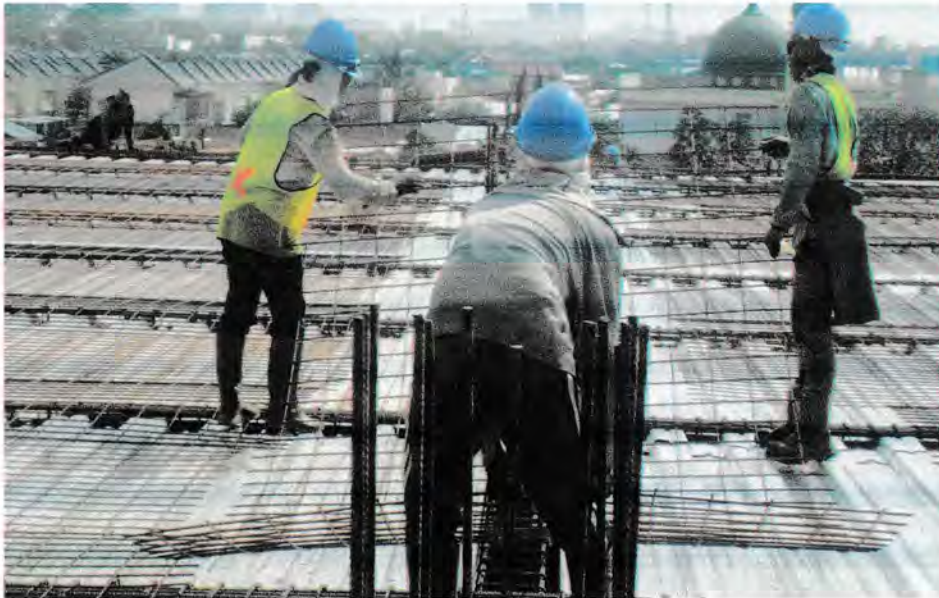
Gambar 3.7 Foto Bekisting Plat Lantai
