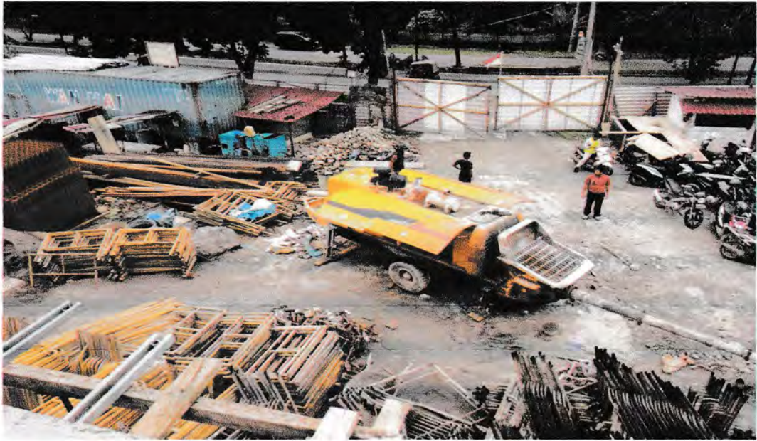
Gambar 5.3 Proses Pemasangan Pipa cor
