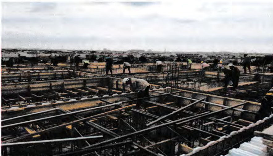
Gambar 3.9 Foto Penulangan Balok
