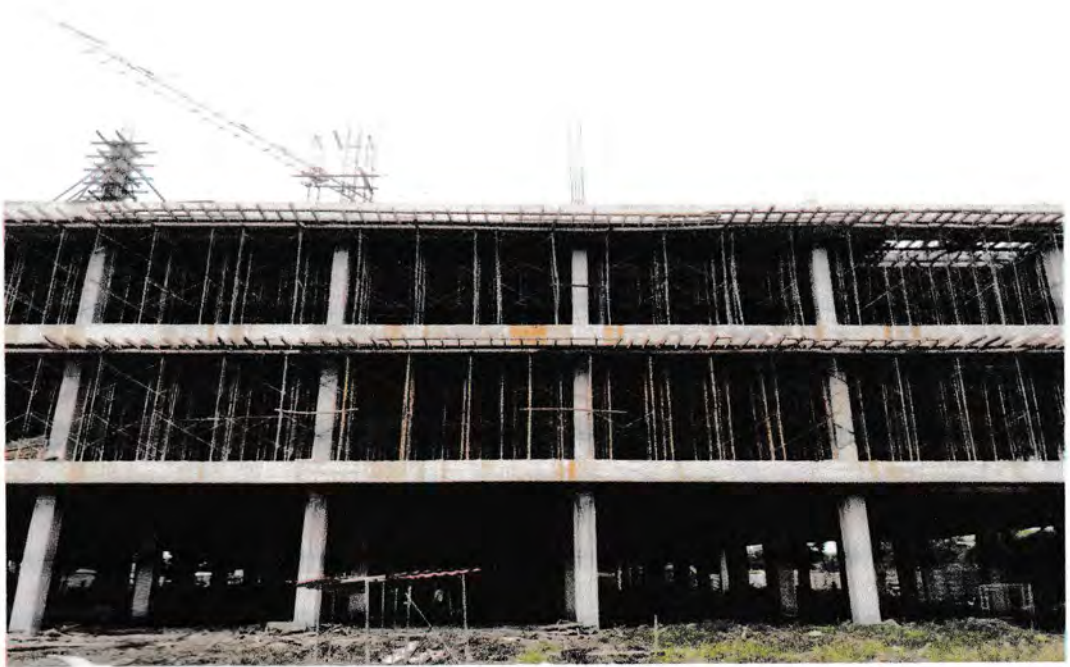
Gambar 5.7 Pembangunan Struktur Suzuya
