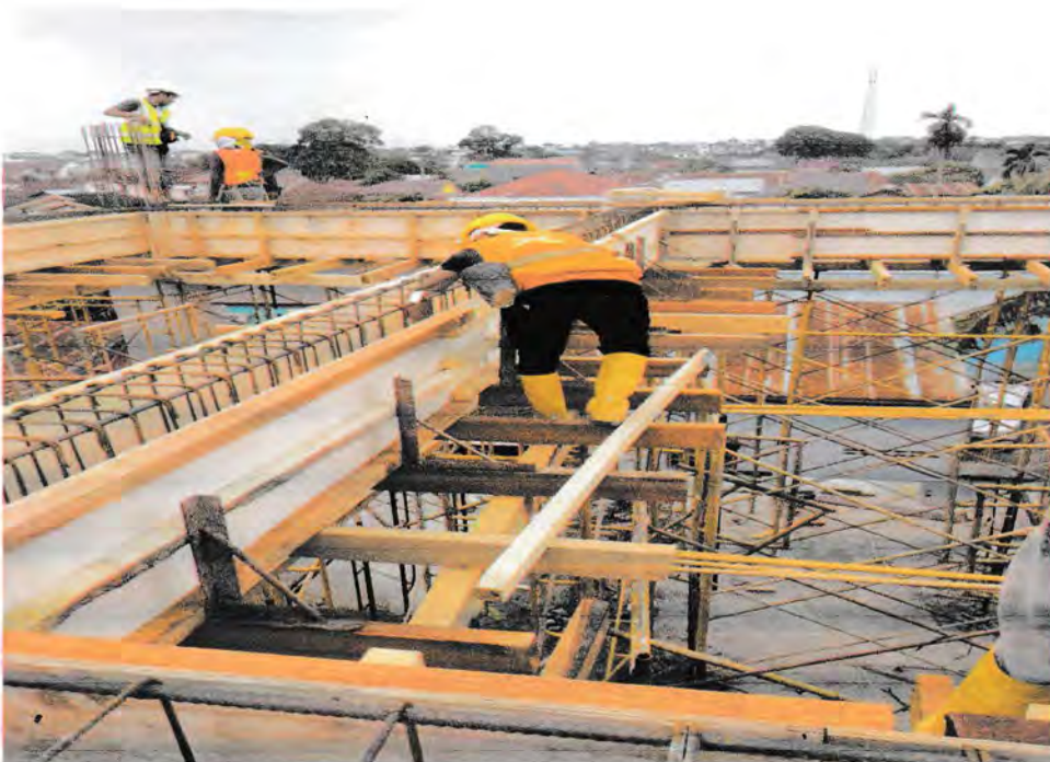
Gambar 3.6 Foto Bekisting Balok
