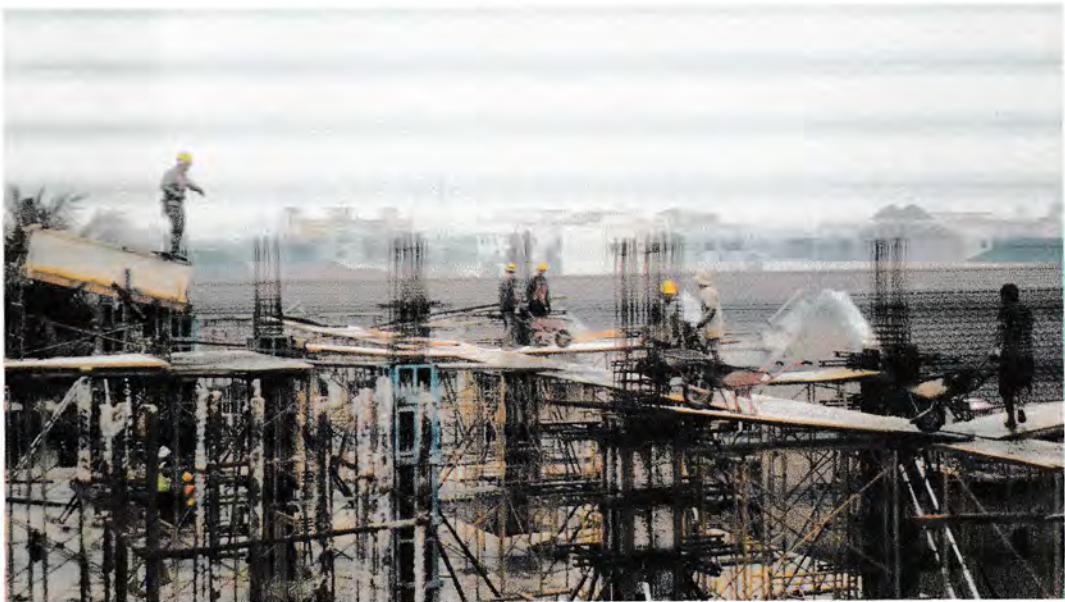
Gambar 5.8 Pengecoran Manual Kolom
