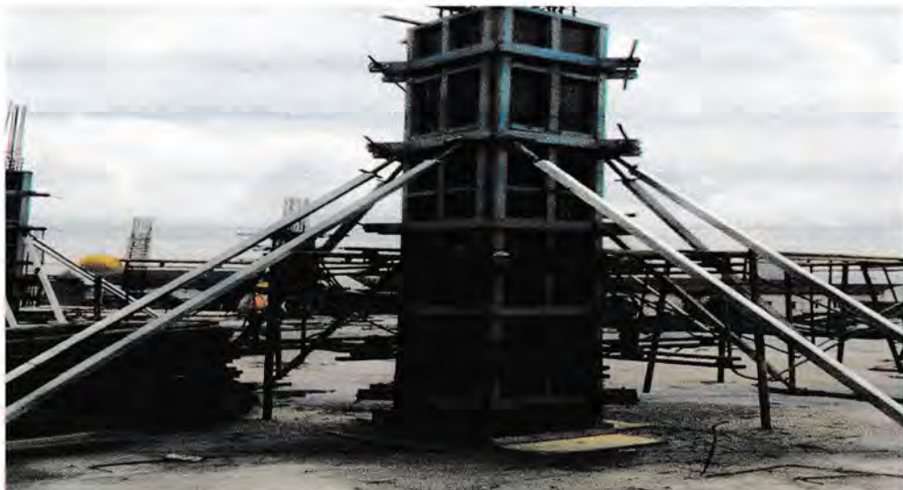
Gambar 3.5 Foto Bekisting Kolom
