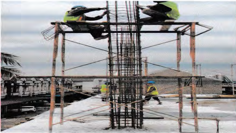
Gambar 3.8 Foto Penulangan Kolom
